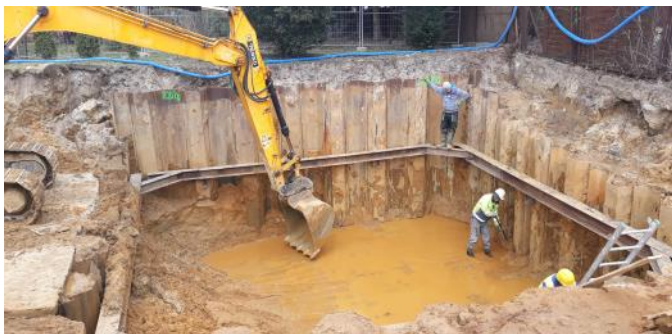
Budowa zbiornika do ścieków
