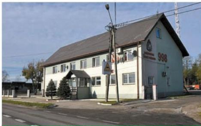
Obecna siedziba dąbrowskich strażaków to kilka budynków, które mają już blisko pół wieku, są żelbetowe i nieocieplone
