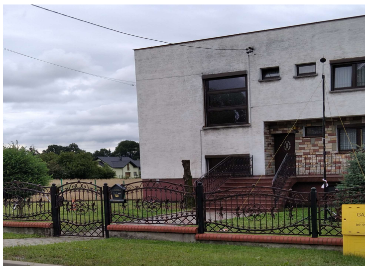
Fot. 1. Pilchowice, RB1. Lokalizacja Punktu Pomiarowego przy ul. Dolna Wieś.
