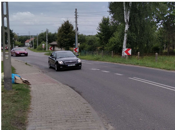
Fot. 5. Pilchowice, RB2. Badany odcinek ul. Gliwickiej w kierunku skrzyżowania z ul. Bierawką.
