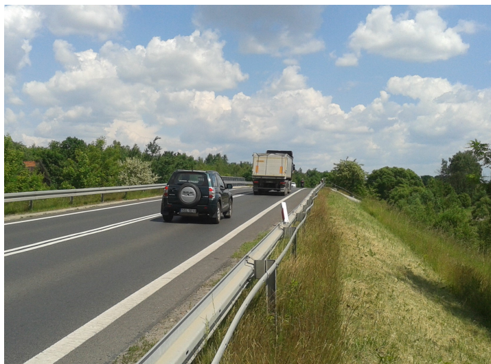
Fot. 14. Nieborowice, RB5. Badany odcinek ul. Rybnickiej (DK78) w kierunku Gliwic.
