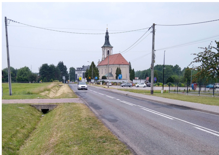
Fot. 8. Stanica, RB3. Badany odcinek ul. Gliwickiej w kierunku ul. 1-go Maja.
