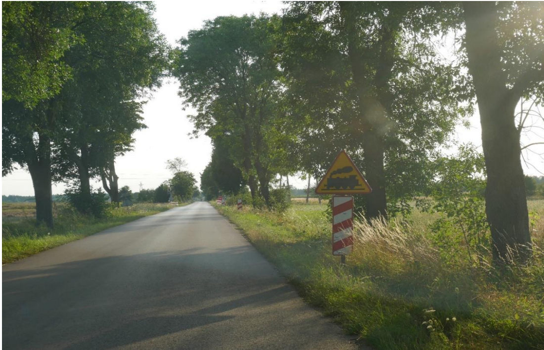
Zdjęcie 1 - Widok na przejazd kolejowo-drogowy (od strony jadącego samochodu) [źródło: fot. własne Zespołu badawczego]
