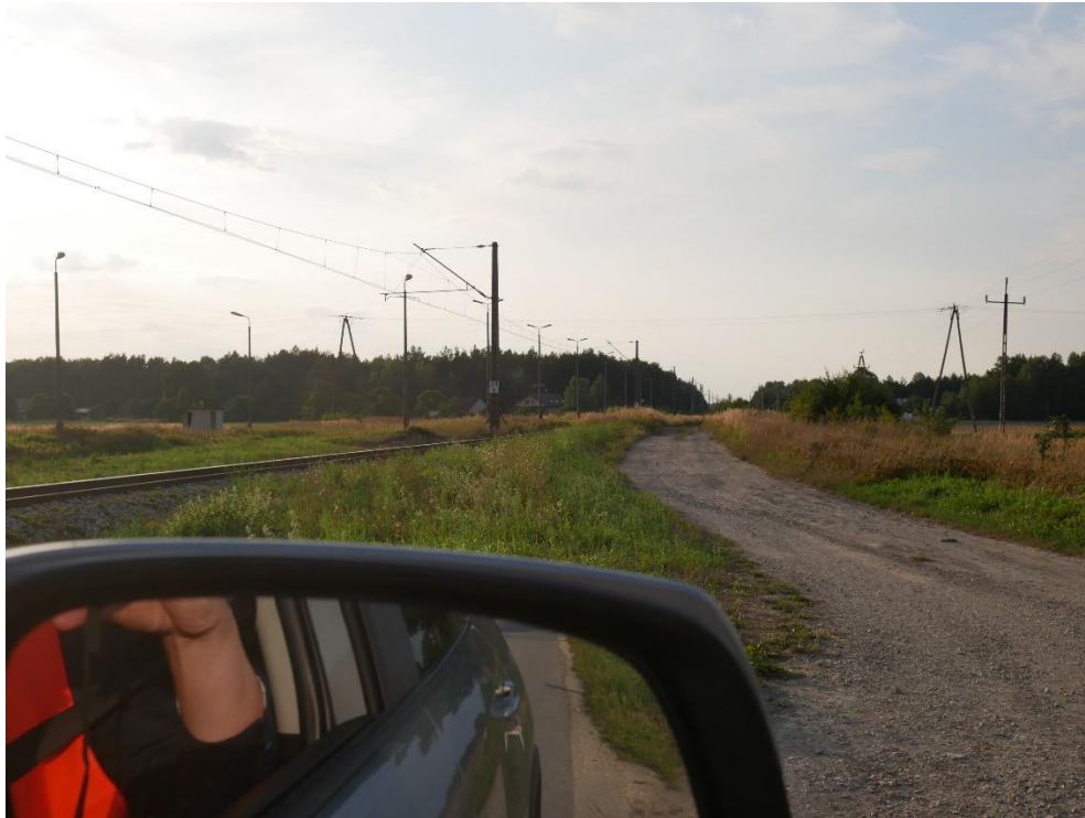
Zdjęcie 12 - Widok z odległości 10 m (droga na nasypie przesłaniająca widoczność)
