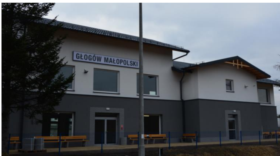
Fot. 4. Budynek dworca PKP w miejscowości Głogów Małopolski.
