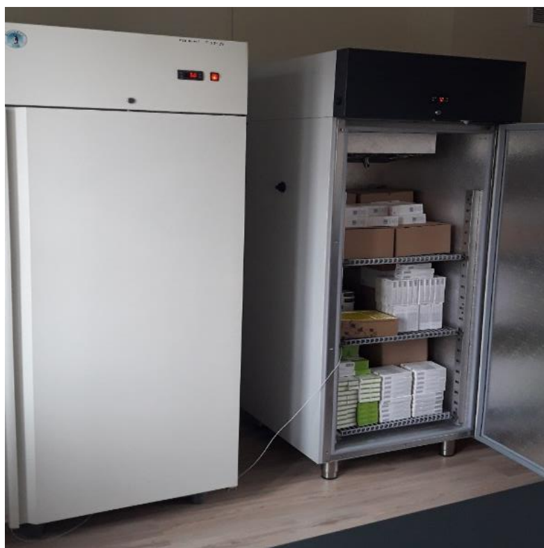
Fot. 1. Magazyn szczepionek w Powiatowej Stacji Sanitarno–Epidemiologicznej w Rzeszowie.
