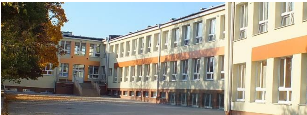
Rys. 3.1. Widok szkoły podstawowej po termomodernizacji
