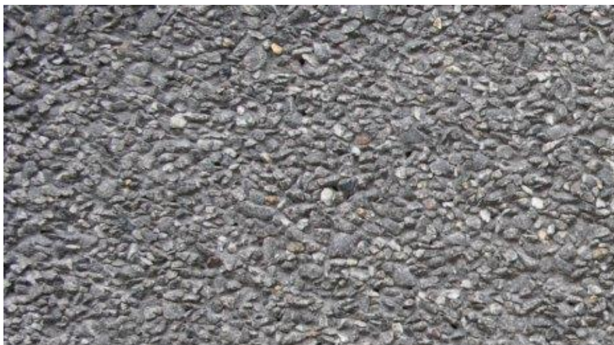
Rys. 4-23 Przykład nawierzchni z betonu cementowego teksturowanego metodą odkrytego kruszywa 39
