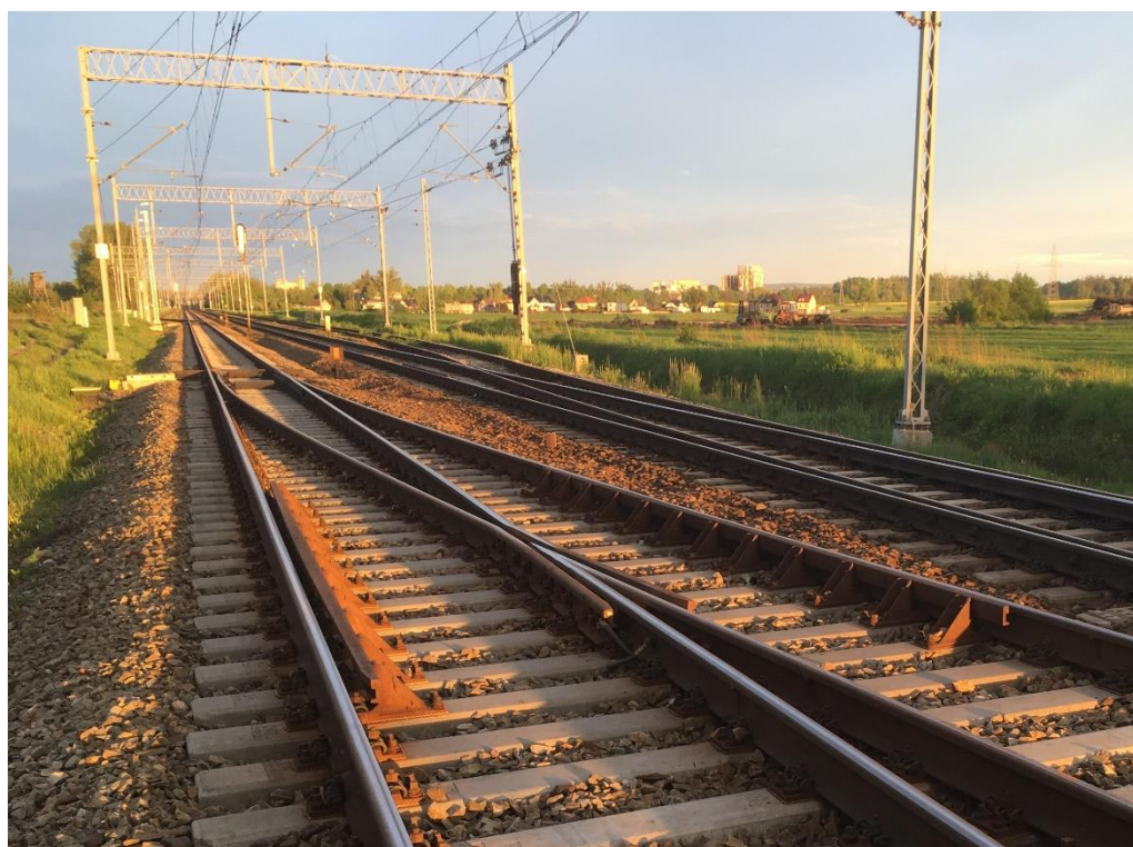
Rys. 5-14 Dwa rozjazdy zwykłe na torze prawym i jeden rozjazd zwykły na torze lewym (tor główny + tor zwrotny). Zdjęcie wykonane na linii kolejowej nr 132 w m. Tarnów Opolski, woj. opolskie (km. 85+600)
