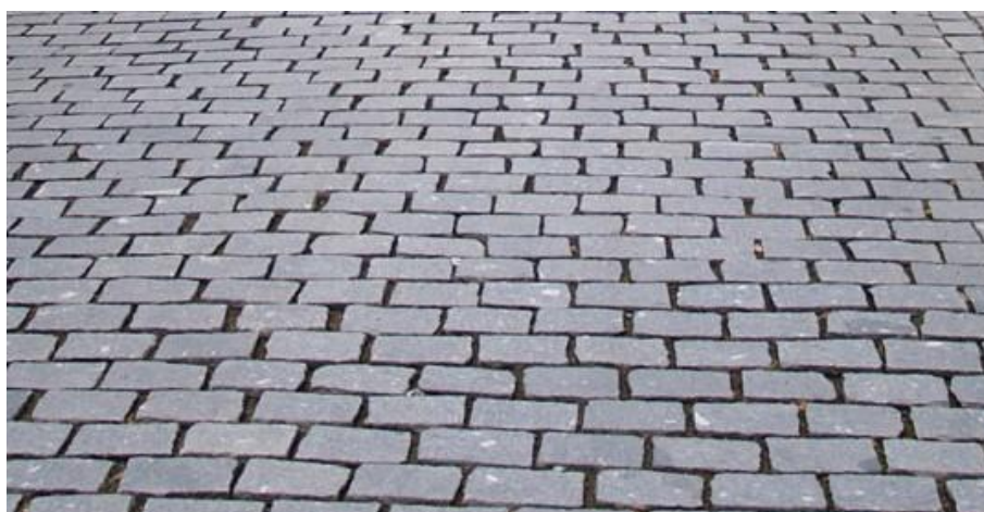
Rys. 4-25 Przykład nawierzchni z betonowej kostki brukowej 43
