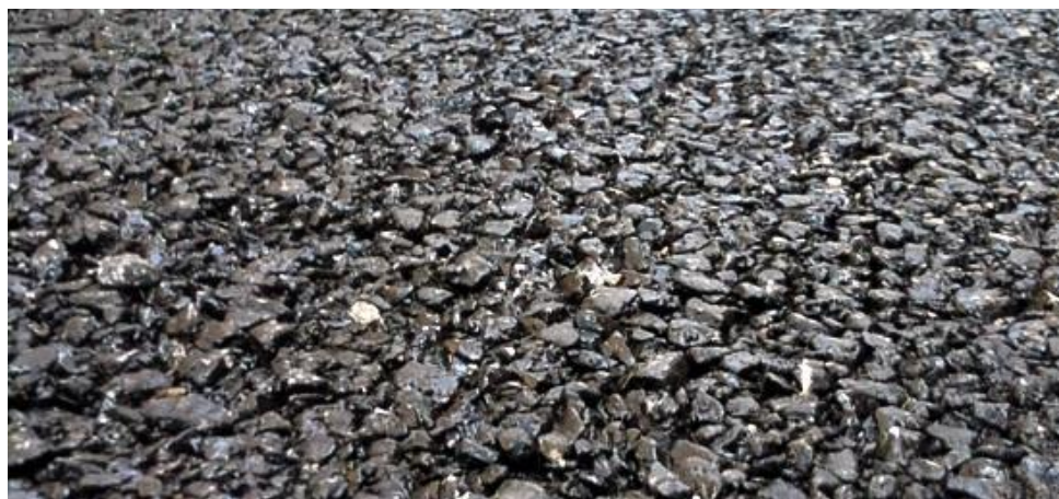
Rys. 4-20 Przykład nawierzchni PA – jedna warstwa 37
