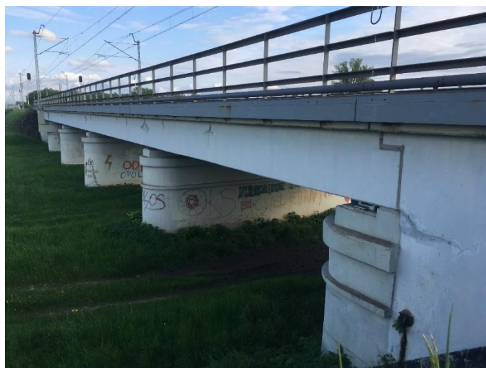
Rys. 5-31 Współczesny most betonowy. Linia kolejowa nr 132 na wysokości Lewina Brzeskiego, woj. opolskie
