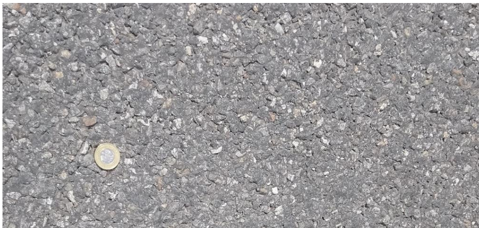
Rys. 4-16 Przykład nawierzchni SMA 8 33
