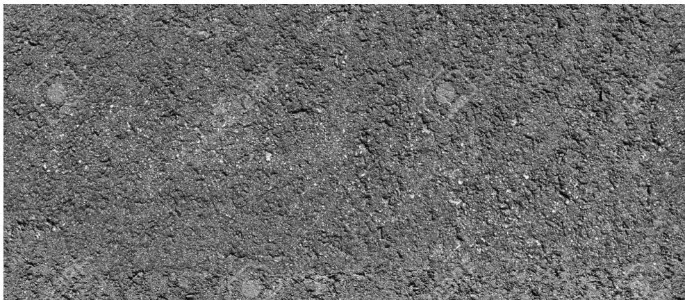
Rys. 4-18 Przykład nawierzchni DAC 34
