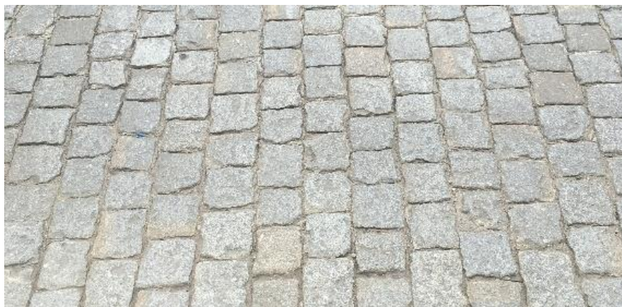
Rys. 4-24 Przykład nawierzchni z kostki kamiennej 41
