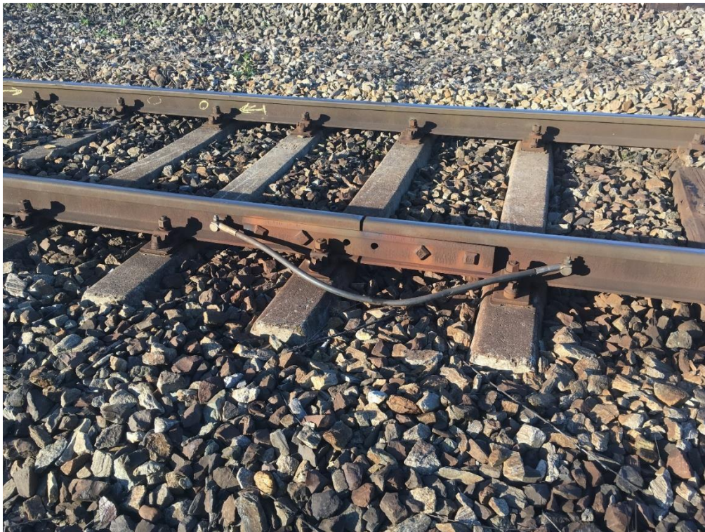
Rys. 5-7 Typowe torowisko na podsypce, z podkładami strunobetonowymi, z jednym stykiem na 100 m, standardowo utrzymane, bez dodatkowych elementów ograniczających emisję hałasu, na tuku o krzywiznie 1000 – 500 m. Linia kolejowa nr 277, tor 1, na terenie m. Opola, km 5,170 - 5,300
