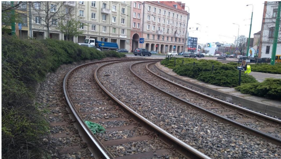
Rys. 5-20 Łuk torów tramwajowych o promieniu r < 300\text{m} – rozstaw szyn 1435 mm
