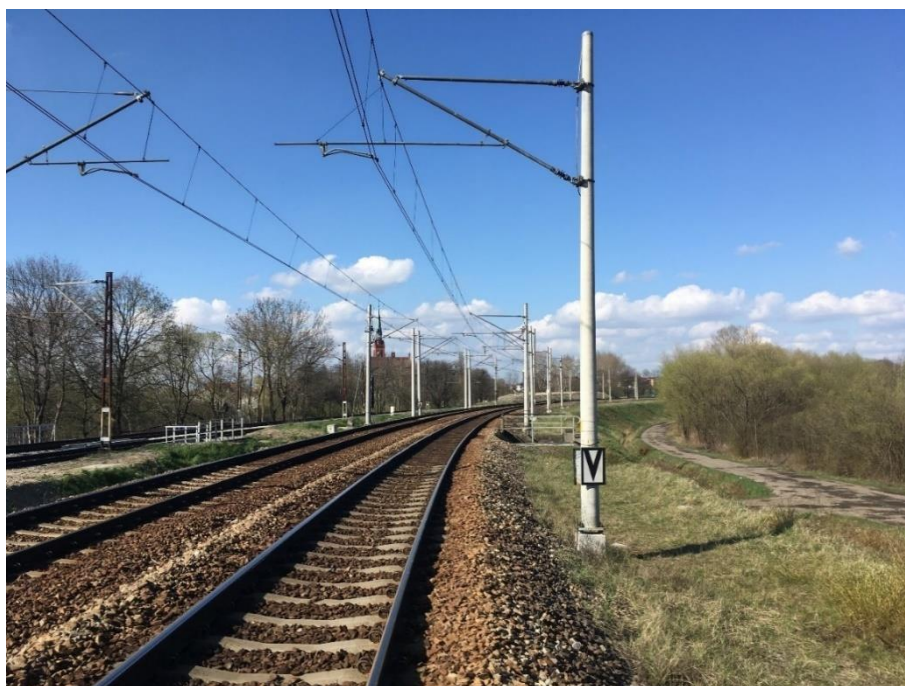
Rys. 5-5 Typowe torowisko na podsypce tłuczniowej, bezstykowe, dobrze utrzymane, bez dodatkowych elementów ograniczających emisję hałasu, na łuku o krzywiźnie 500 – 300 m. Linia kolejowa nr 277, na terenie m. Opola, w km 0,917- km 1,119
