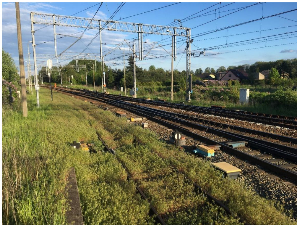
Rys. 5-13 W oddali skrzyżowanie torów, a bliżej rozjazdy zwykłe (tor główny + tor zwrotny) na linii kolejowych 61 Kielce – Fosowskie i linii 144 Opole – Tarnowskie Góry
