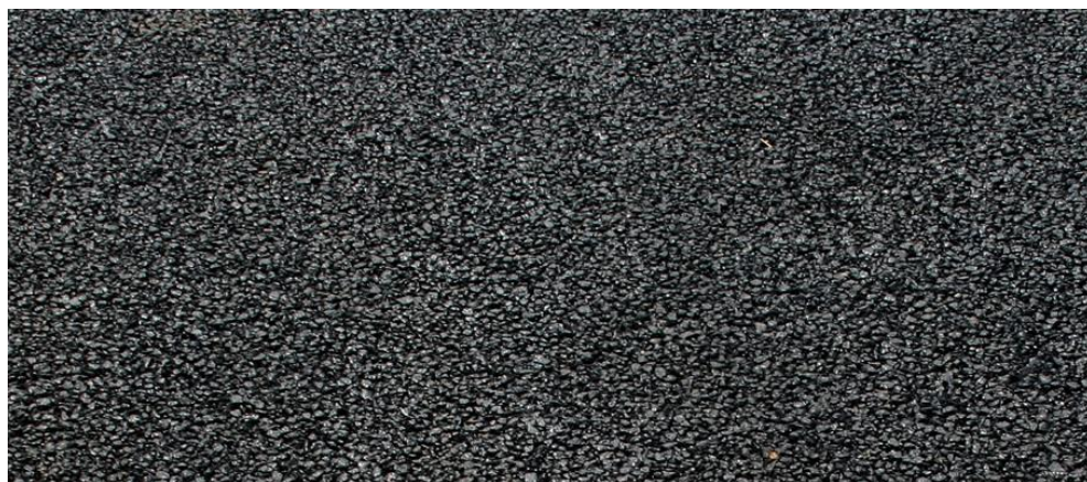
Rys. 4-19 Przykład nawierzchni BBTM 35
