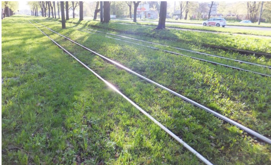
Rys. 5-21 Torowisko tramwajowe zabudowane zielenią – rozstaw szyn 1000 mm
