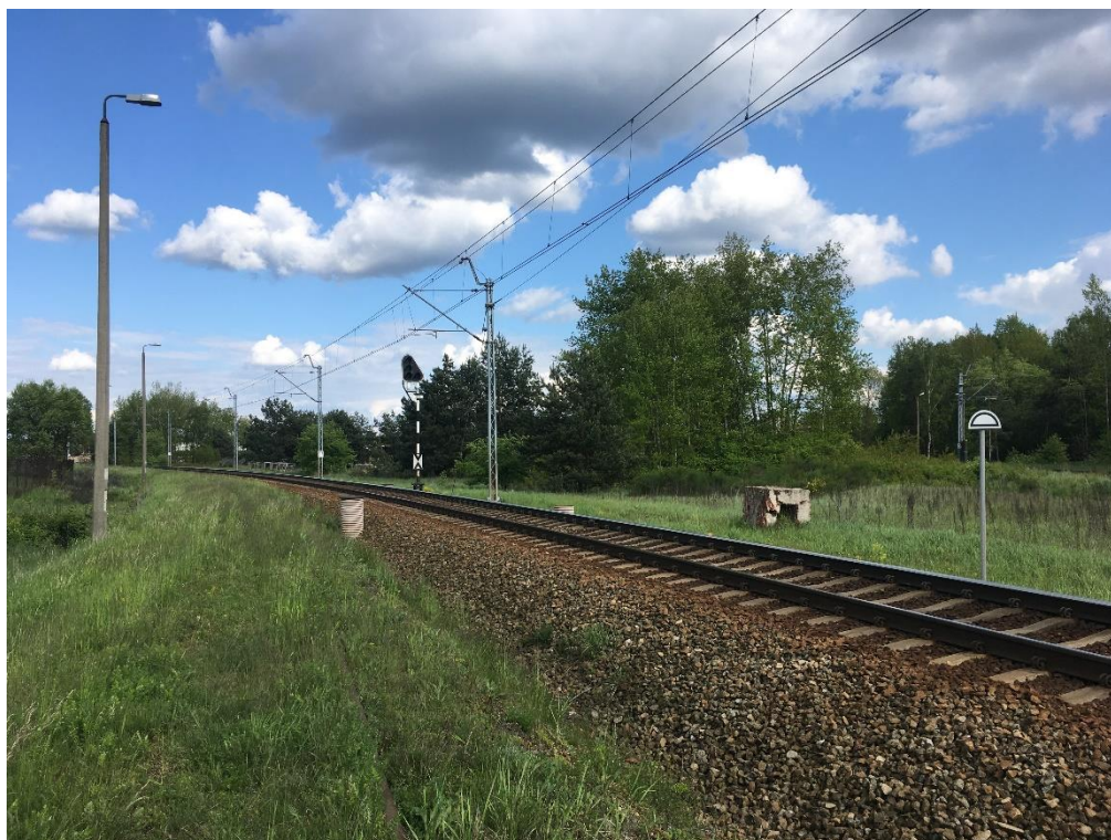
Rys. 5-15 Łuk torowiska r < 500 m na linii kolejowej nr 61 Kielce – Fosowskie, m. Fosowskie, woj. opolskie (km. 175+300) z poprzecznym pochyleniem toru umożliwiającym pokonywanie łuku z większą prędkością
