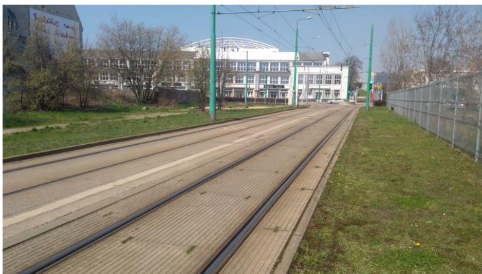
Rys. 5-19 Torowisko tramwajowe zabudowane z szyną w otulinie gumowej – rozstaw szyn 1435 mm
