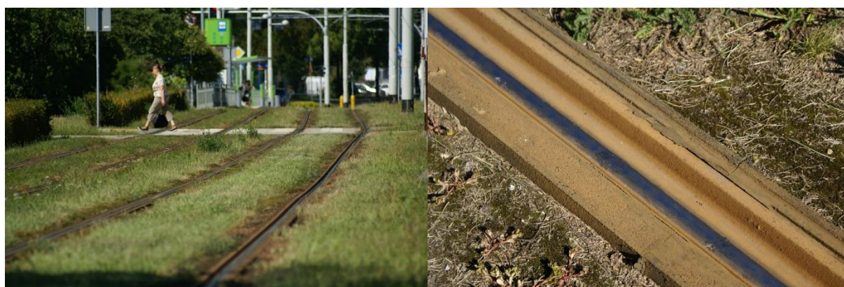
Rys. 5-16 Torowisko tramwajowe zielone w otulinie gumowej – rozstaw szyn 1435 mm
