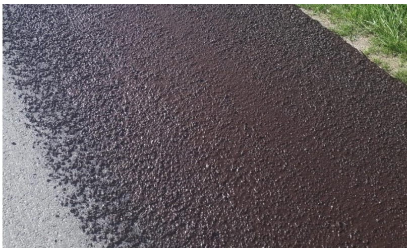
Rys. 4-26 Przykład nawierzchni z cienkiej warstwy na zimno 45
