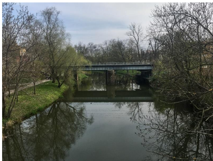
Rys. 5-30 Most kolejowy stalowy z torem na podsypce, podkładami drewnianymi, stykowymi połączeniami torów, zlokalizowany na linii 132 w km 99+634, m. Opole
