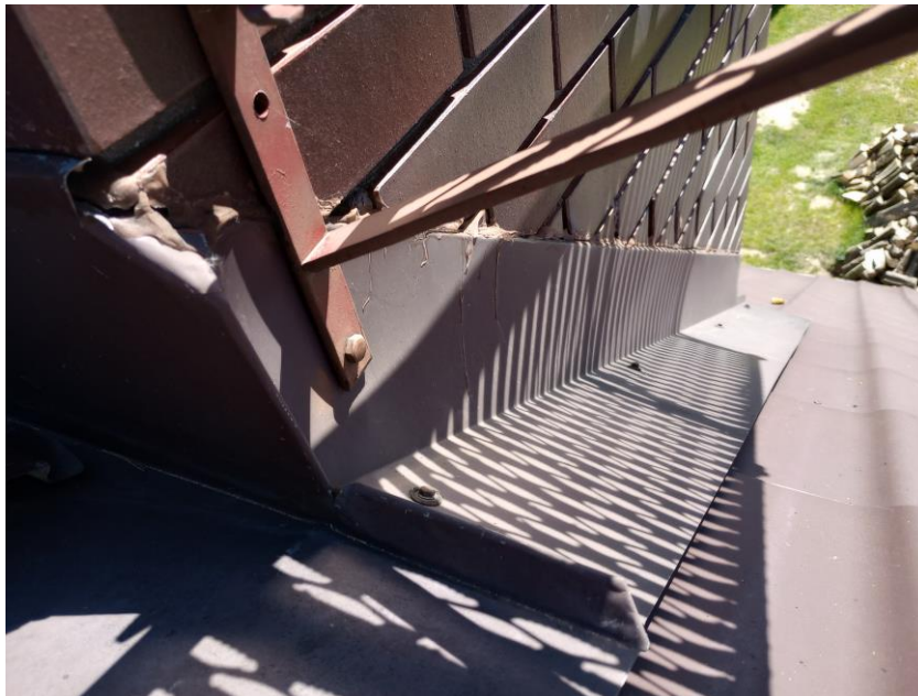
Fot. 3 Komin nr 1 – obróbka komina
