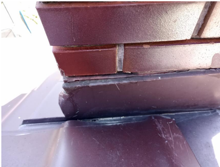
Fot. 4 Komin nr 1 – obróbka komina
