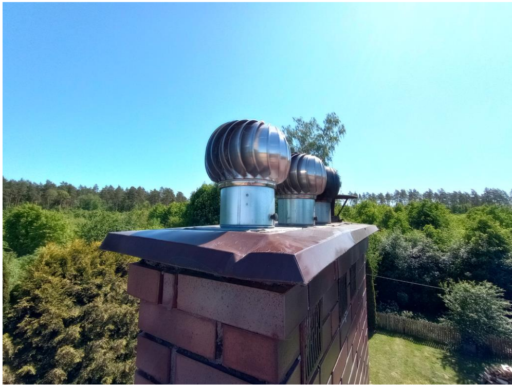
Fot. 5 Komin nr 1 – obróbka czapy kominowej
