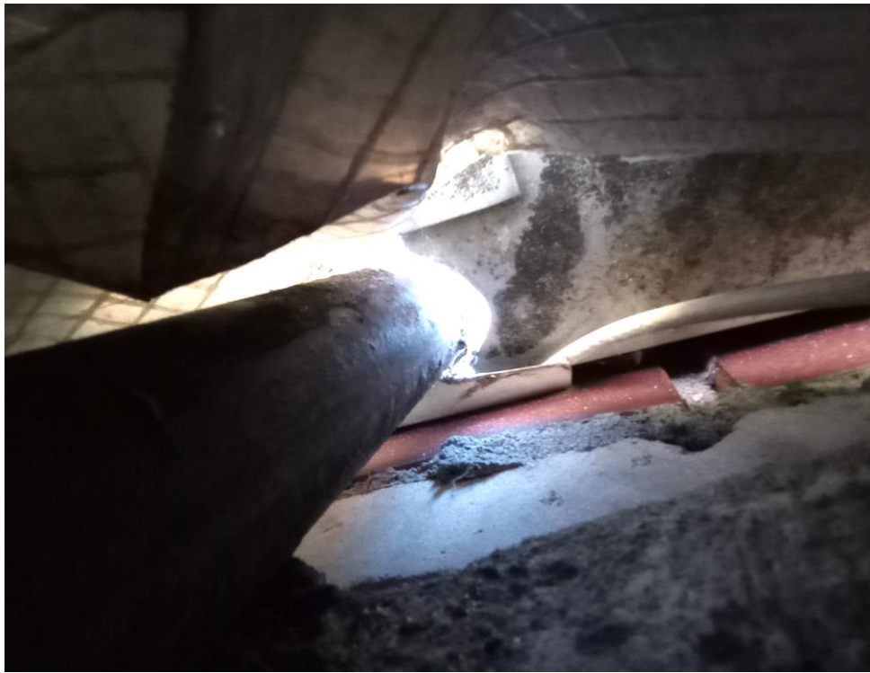
Fot. 7 Komin nr 2 – przejście przez dach rury
