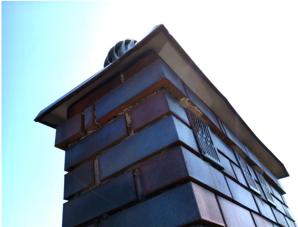
Fot. 6 Komin nr 1 – obróbka czapy kominowej
