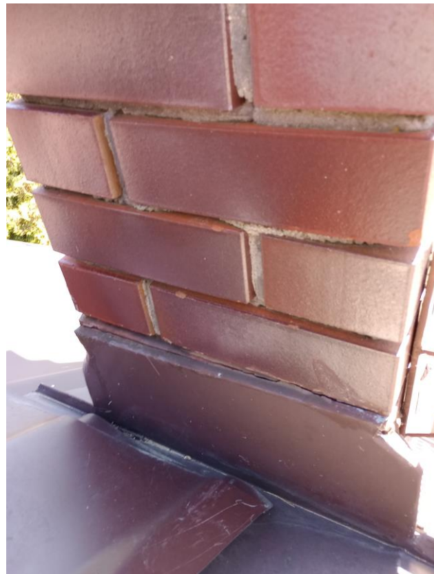
Fot. 2 Komin nr 1 – obróbka komina
