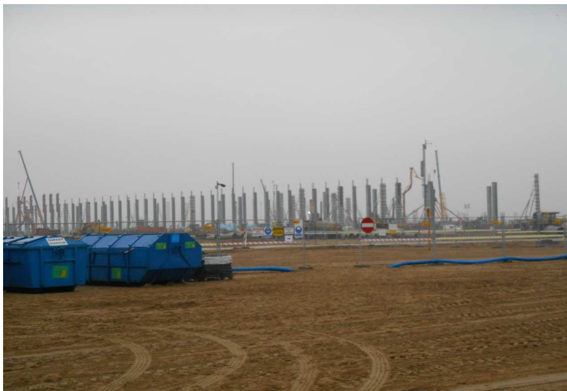
Pierwsza wizyta pracowników Nadzoru Sanitarnego na terenie budowy (grudzień 2014r)
