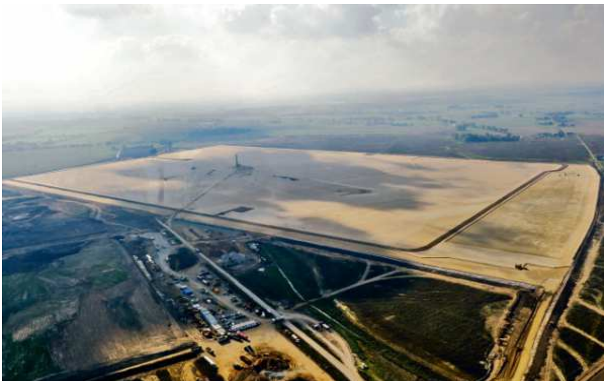
Rozpoczęcie budowy (październik 2014r)
