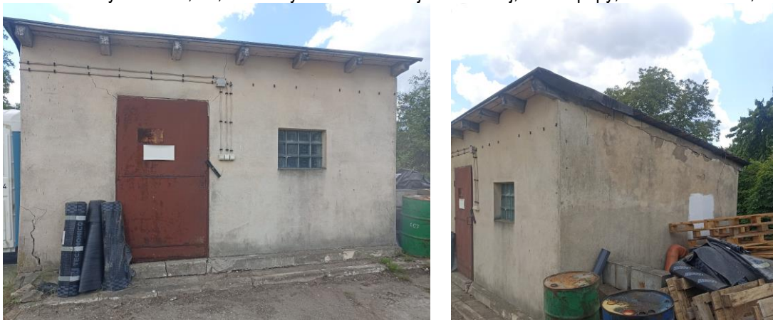
Zdj. 1-2. Budynek gospodarczy do rozbiórki
