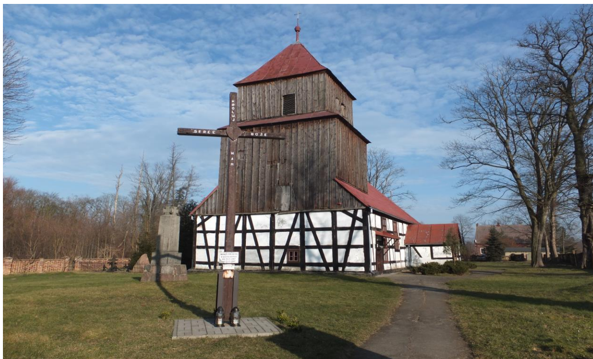
Ryc. 36. Kościół o konstrukcji ryglowej z wypełnieniem ceglany (Fot. Radosław Parkoła).
