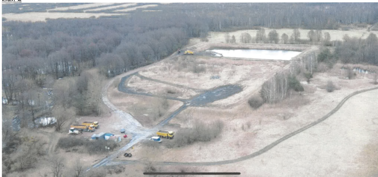
Fot. 2. – zdjęcie z drona w trakcie wysypywania odpadów do kwatery odpadów ciekłych - 8.02.2024
