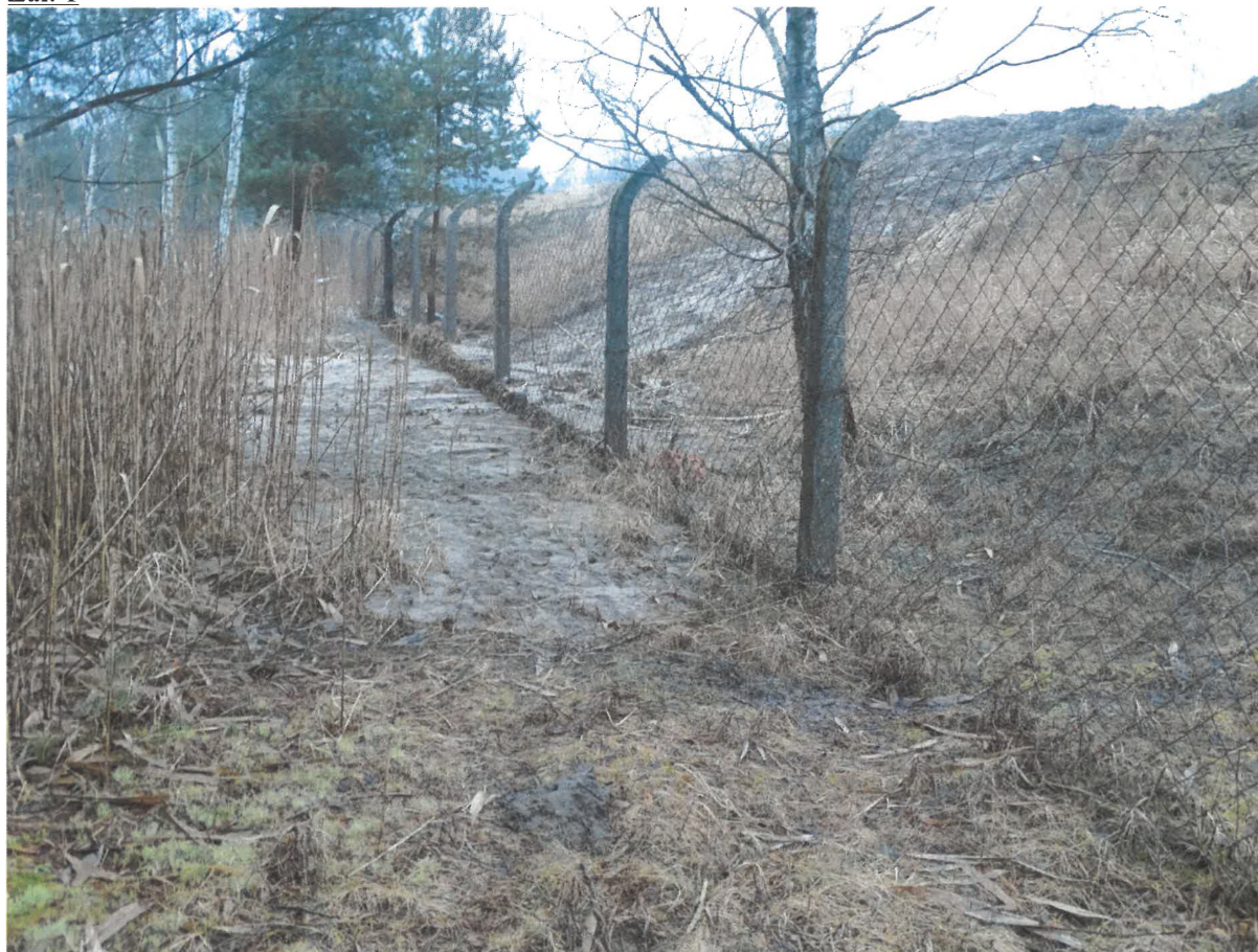
Fot 1. – przekopana ściana kwatery odpadów ciekłych, przez którą wylewano skażoną ciecz na pobliskie łąki i lasy (kilkaset m od rzeki Noteć) – 10.02.2024
