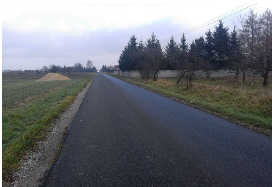
Rys. 5.4 Widok ogólny odcinka badawczego
