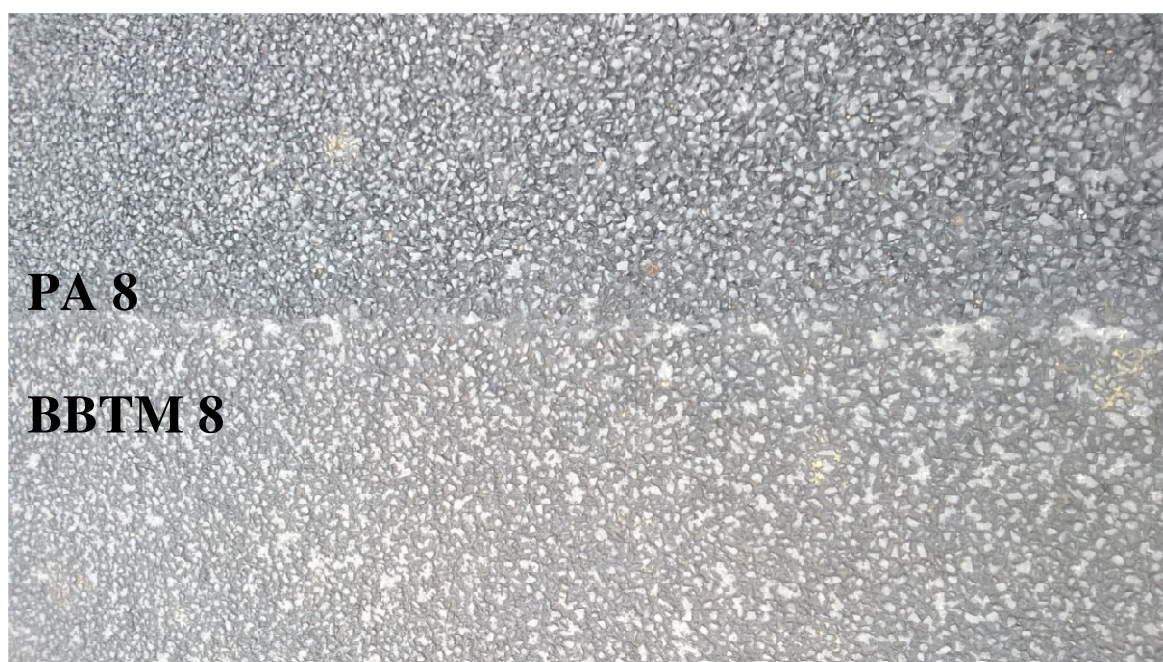
Rys. 5.5 Porównanie wyglądu warstw ścieralnych odcinka badawczego
