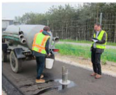
Rys. 5.33 Pomiar wodoprzepuszczalności metodą in-situ
