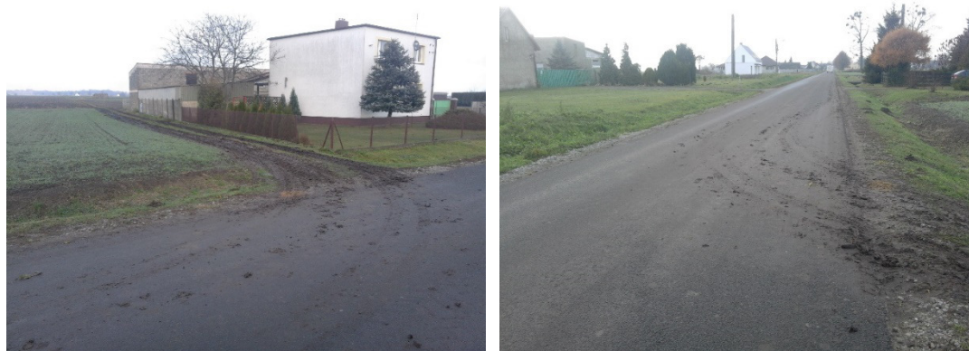
Rys. 5.6 Zanieczyszczenie odcinka badawczego w rejonie wjazdów z pól
