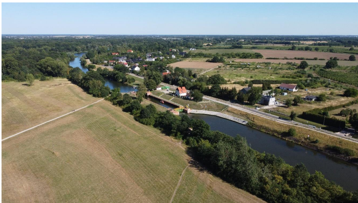
Ryc. 18 Budowa budowli hydrotechnicznej na rzece poza obszarem Natura 2000, która dalej przepływa przez ten obszar, może mieć negatywny wpływ na przedmioty ochrony
