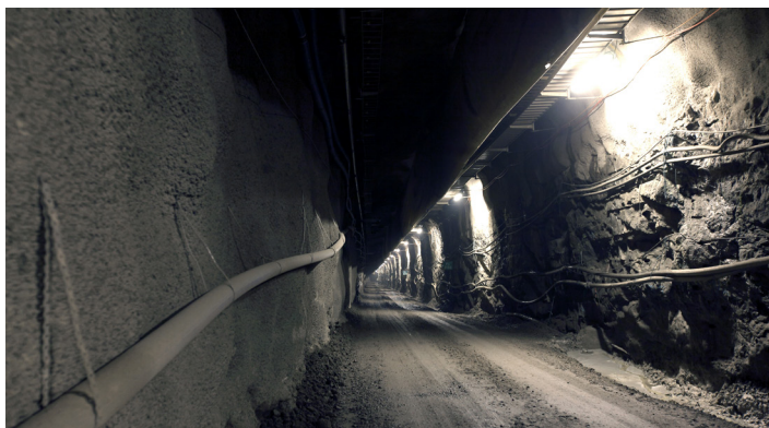
Fot. 5. Częściowo wydrążony tunel komunikacyjny w składowisku ONKALO w Finlandii. (fot. Posiva Oy)
