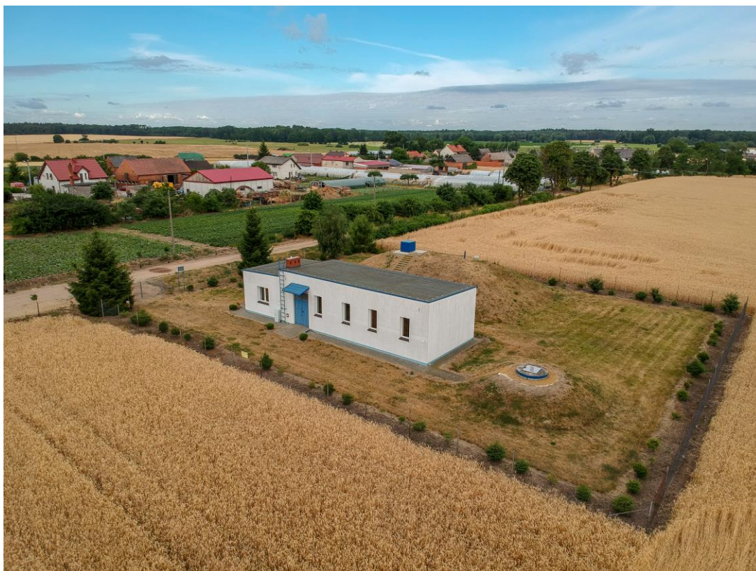
Zdjęcie Nr 1. Stacja Uzdatniania Wody Karzec.
