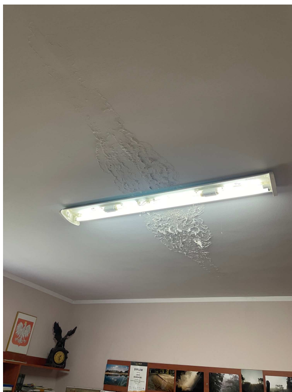
2. Zacieki na sufitach w pomieszczeniach kancelarii
