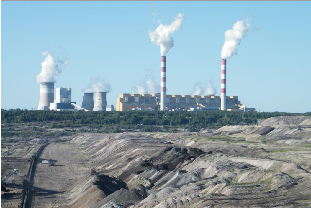
Fot. 10. Elektrownia Belchatów z fragmentem usypywanego zwalowiska wewnętrznego w miejscu odkrywki Pola Belchatów (fot. G. Siemieńczuk)
