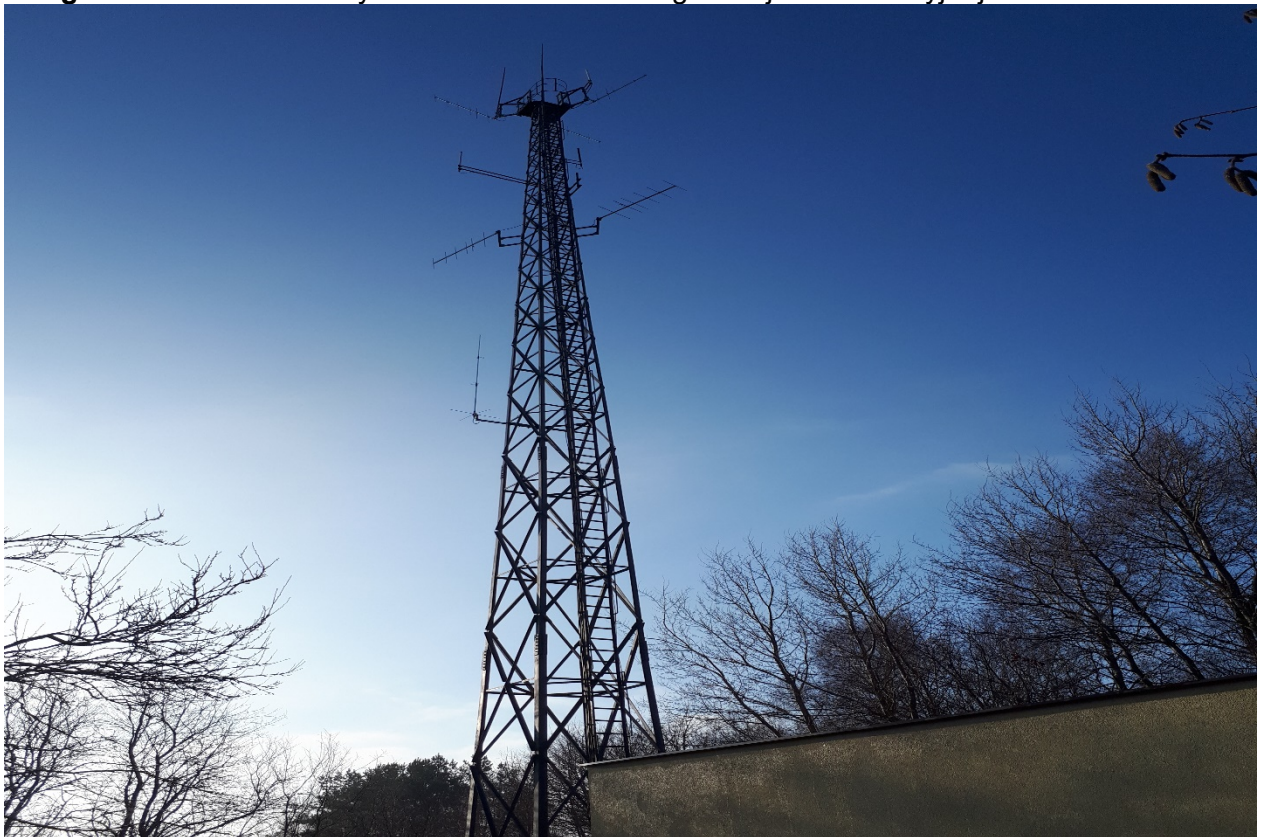
Fotografia nr 2. Widok masztu antenowego.
