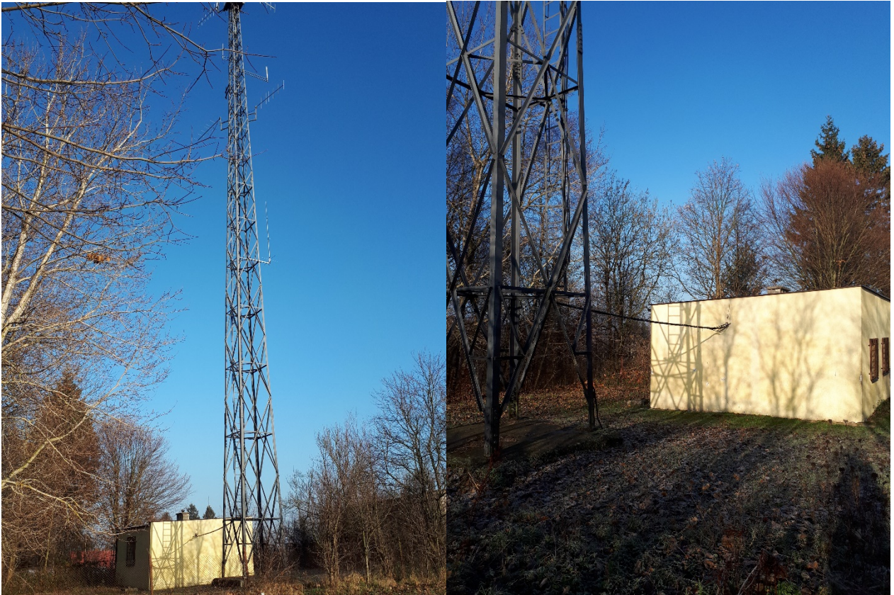
Fotografie nr 1. Widok budynku i masztu antenowego stacji retransmisyjnej.
