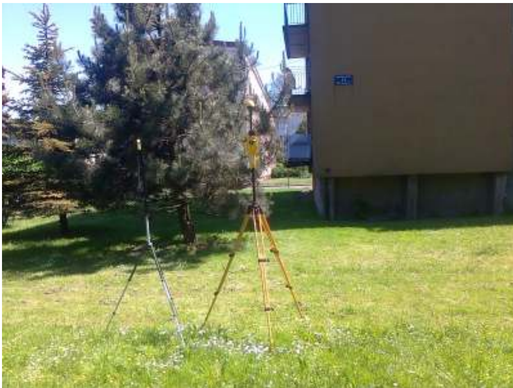
Fot. 3. Rejon badań, widok w kierunku wschodnim
