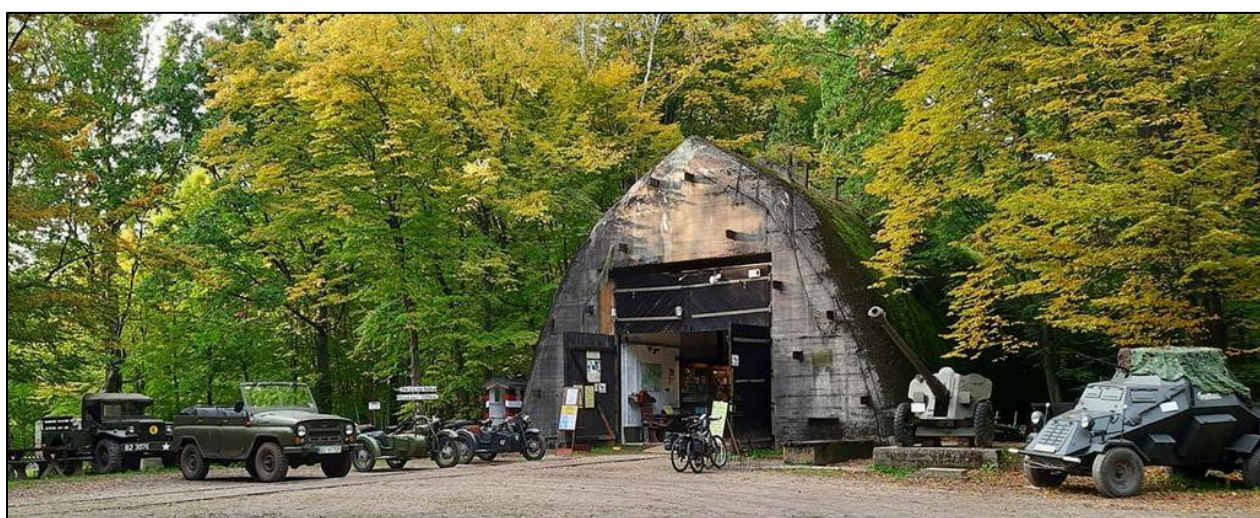
Fot. 9. Schron kolejowy wchodzący w skład niemieckiego Stanowiska Dowodzenia Anlage Mitte z II wojny światowej w L-ctwie Jasień, oddz. 207, opodal wsi Konewka (autor J. Szymański).
