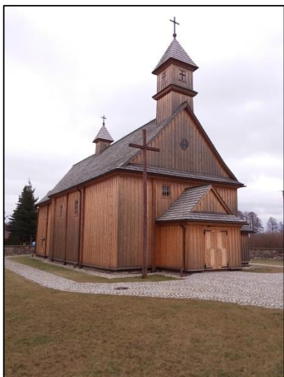
Fot. 3. Modrzewiowy kościół pw. Św. Małgorzaty w Czerniewicach. Badania dendrochronologiczne z 2015 r. wykazały, że ściany zrębowe wykonano z modrzewi ściętych w latach 1422-1423.
