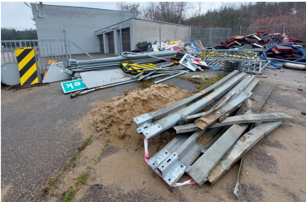
Obwód Drogowy Szczecinek
