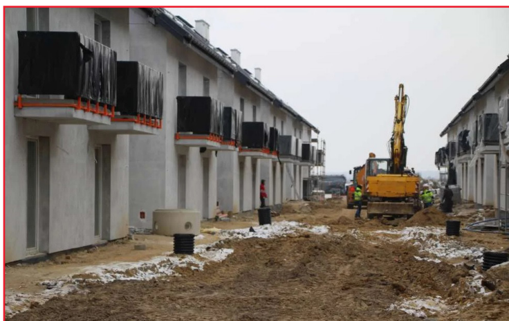
Fot. 2. Budowa Mieszkań Plus w Potarzycy. Źródło: UM w Jarocinie
