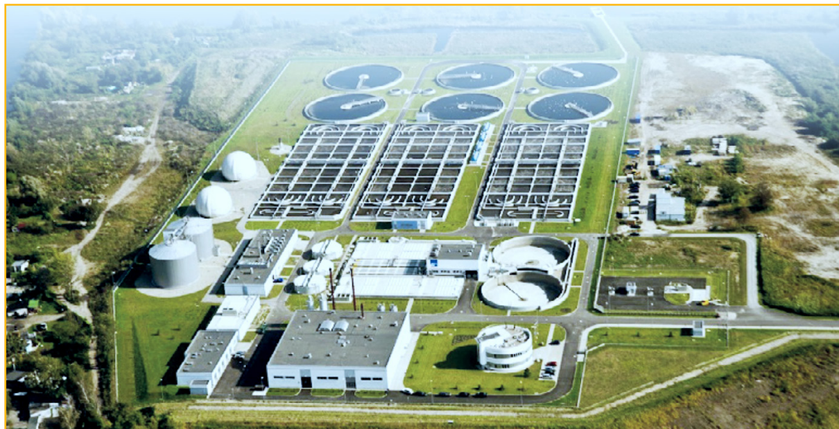
Fot. 13. Komory fermentacji osadu i zbiorniki gazu oczyszczalni ścieków Pomorzany w Szczecinie. Źródło: ZWiK Szczecin
