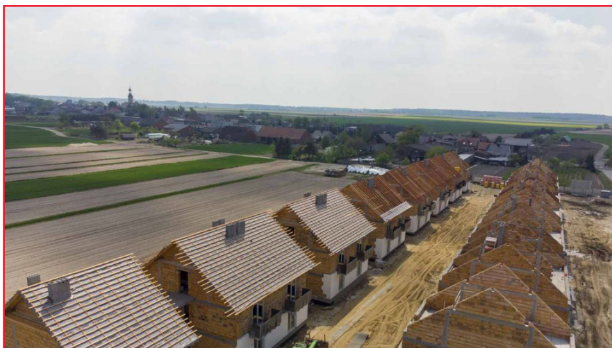
Fot. 1. Budowa Mieszkań Plus w Potarzyca. Źródło: UM w Jarocinie
