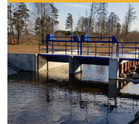
Odbudowany jaz na rzece Rozoga w miejscowości Wykrot
