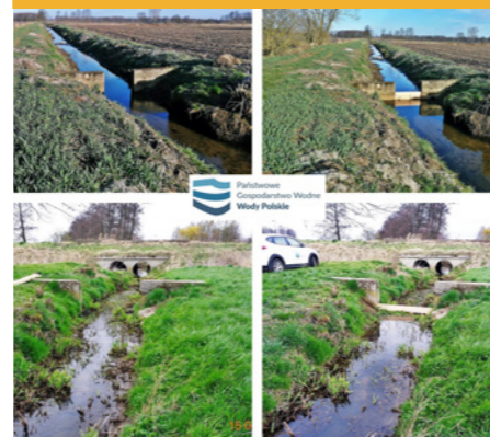
Montaż zastawek na małych obiektach piętrzących. Rzeka Błotnia i Struga Lutynia
