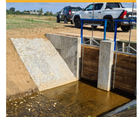
Wyremontowany jaz w miejscowości Żelazna koło Grodkowa
