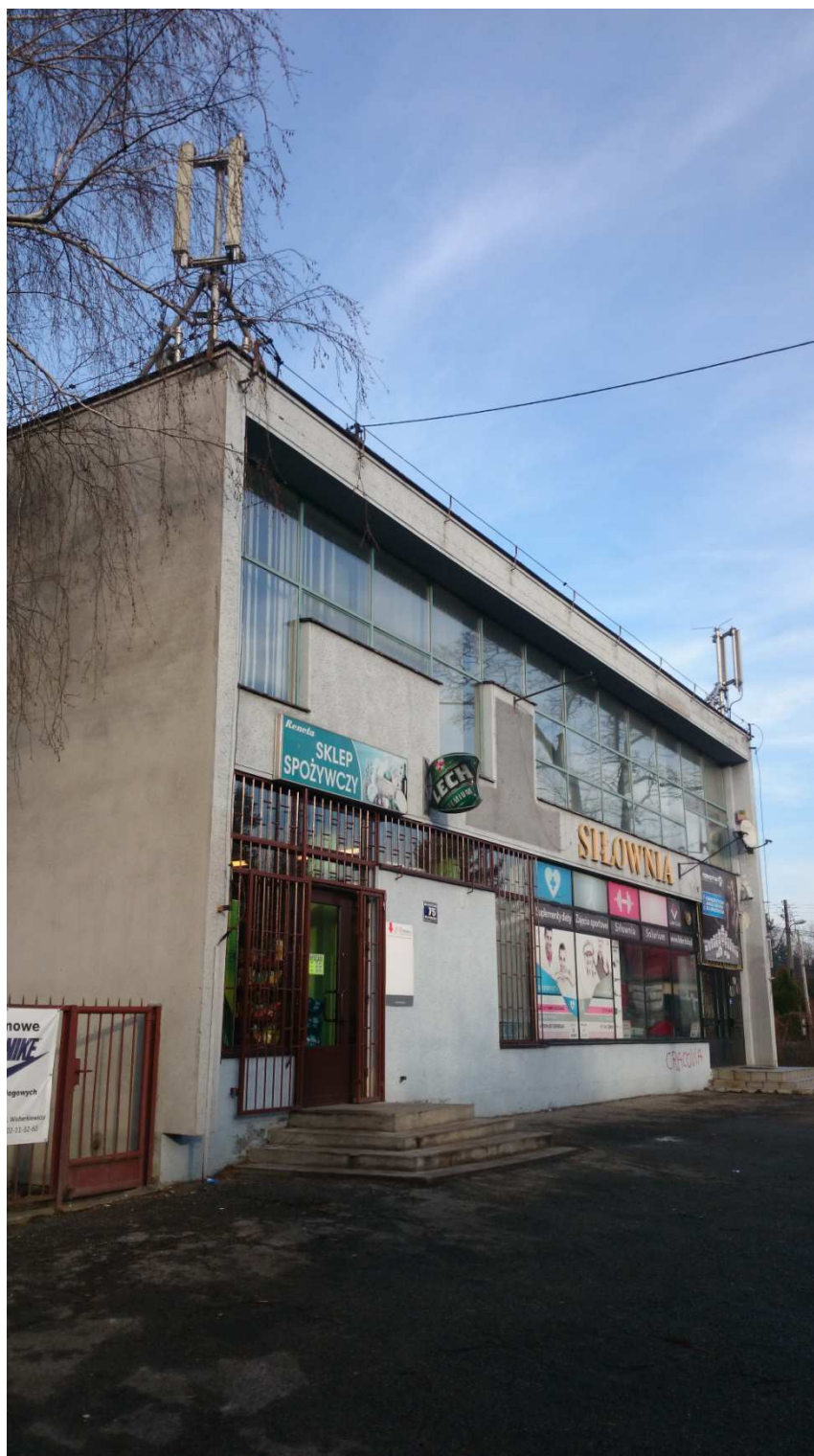
Fot. 1: Widok anten stacji bazowej ID stacji: KRA0222_D zlokalizowanej na dachu budynku użyteczności publicznej w Krakowie przy ul. Kąpielowej 75
