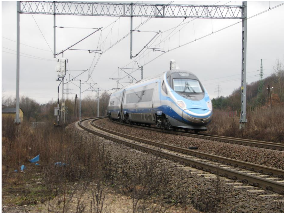
Fot. 2. Kusięta, przejazd pociągu, widok w kierunku Koniecpola.
