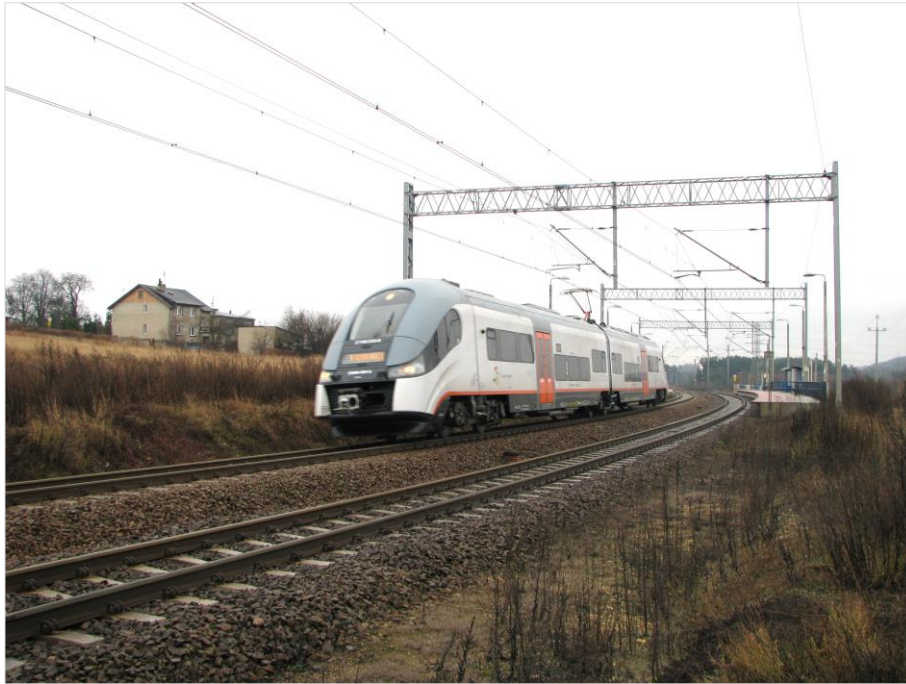
Fot. 1. Kusięta, przejazd pociągu, widok w kierunku Częstochowy.
