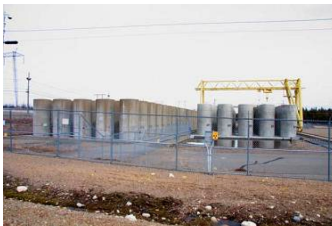
Rys. 3. Betonowy silos w Point Lepreau.
