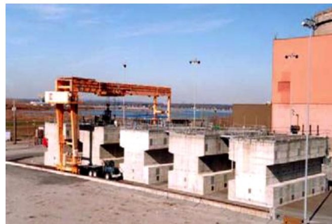
Rys. 2. Przykład systemu przechowywania typu „vault” w elektrowni Gentilly-2 w Kanadzie.
