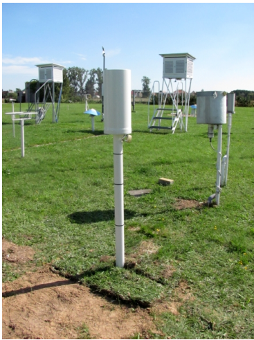
Rys. 3. Nowa stacja IMGW.
