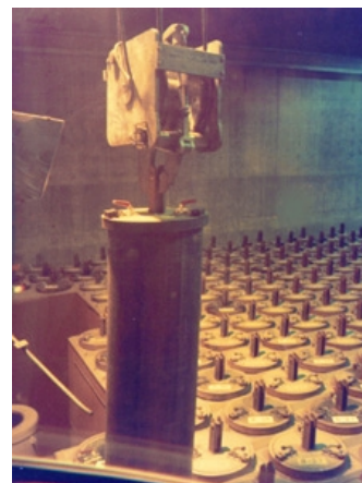
Rys. 1. Przykład systemu przechowywania typu „vault” w zakładzie przerobu wypalonego paliwa w Idaho.
