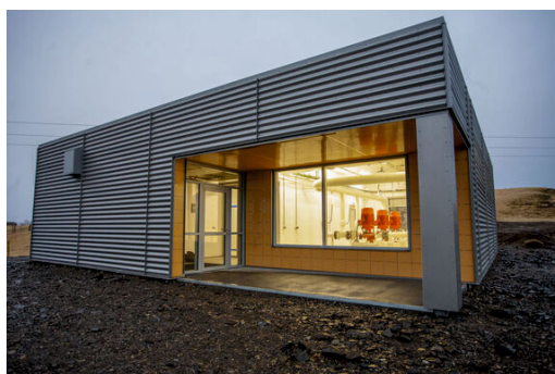
Instalacja geotermalna, Hitaveita Hornafjarðar, źródło: RARIK
