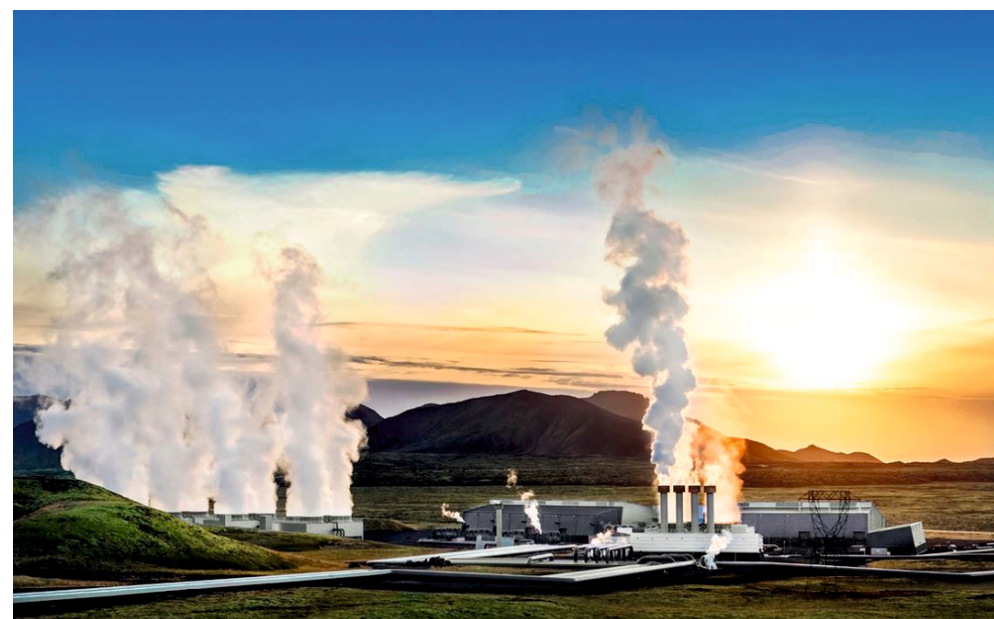
Elektrownia geotermalna, Hellisheiðarvirkjun (Islandia), źródło: Gunnar Svanberg
