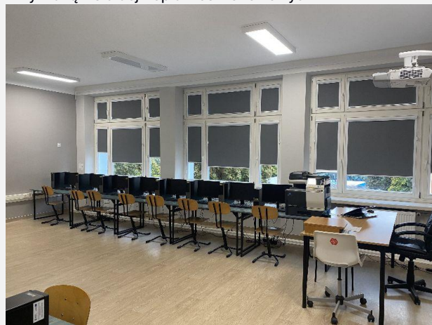
Zdjęcie 21. Sala informatyczna po generalnym remoncie wraz z wymianą instalacji i opraw oświetleniowych
