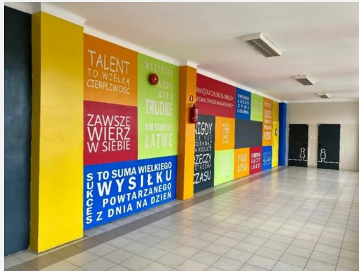
Zdjęcie 2. Ciąg komunikacyjny po remoncie w Publicznej Szkole Podstawowej Nr 4 w Ostrowcu Św.
