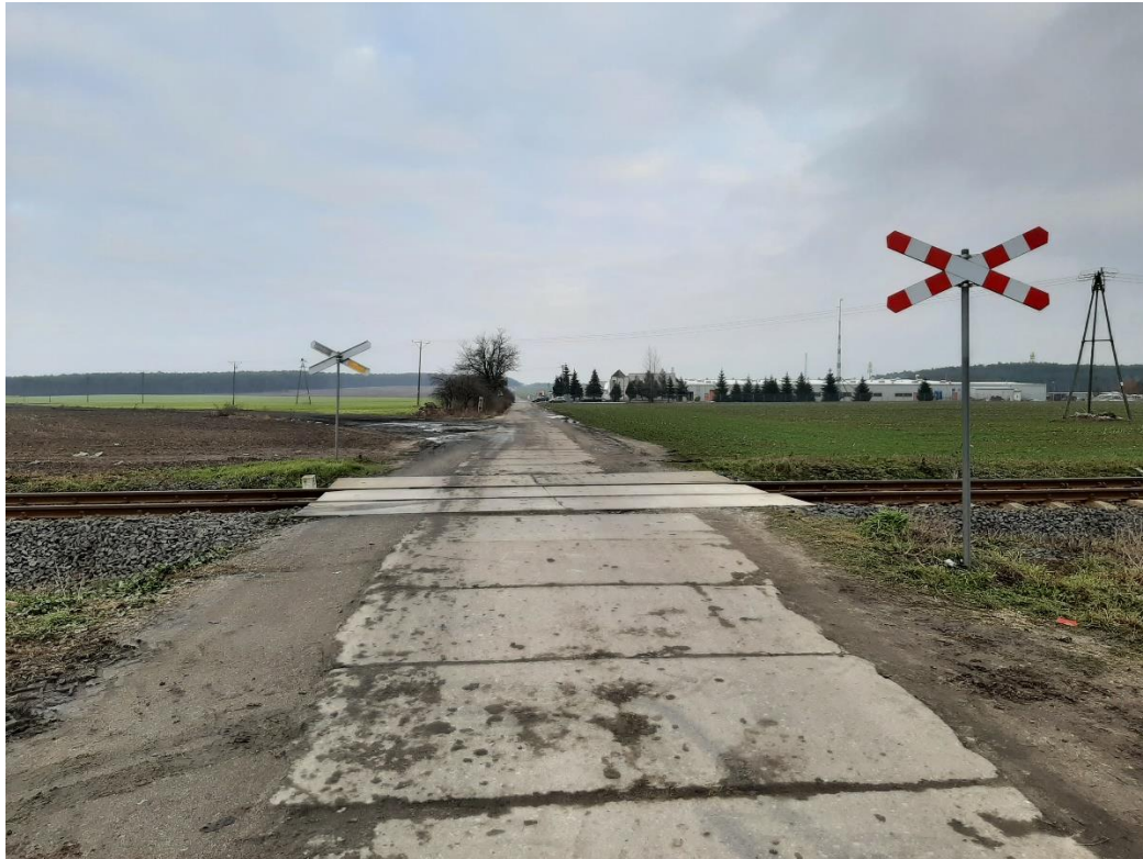
Zdjęcie 7 - Widok przejazdu z kierunku jazdy samochodu ciężarowego
