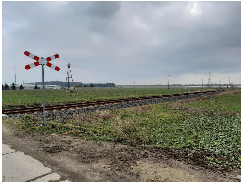
Zdjęcie 6 – Widok na szlak kolejowy od strony drogi dojazdowej z 10m (źródło PKBWK)
