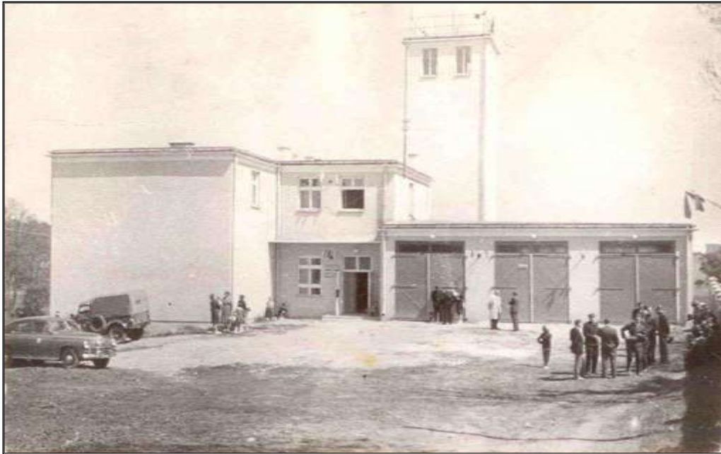
Fot. 7. Remiza OSP Sejny wybudowana w latach 1959 -1962. Źródło: Zdjęcie z Izby Tradycji Pożarniczej przy KP PSP w Sejnach
