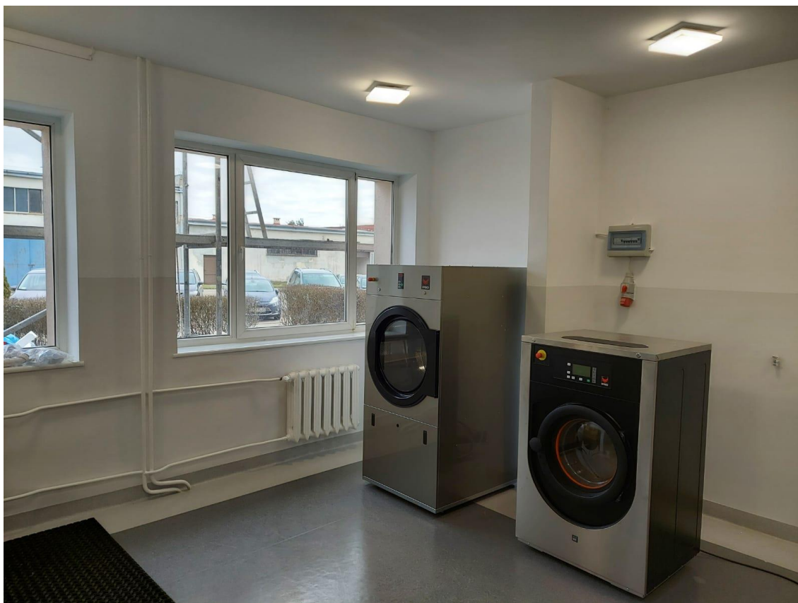
Pralnia JRG Nr 1 w Bytowie
