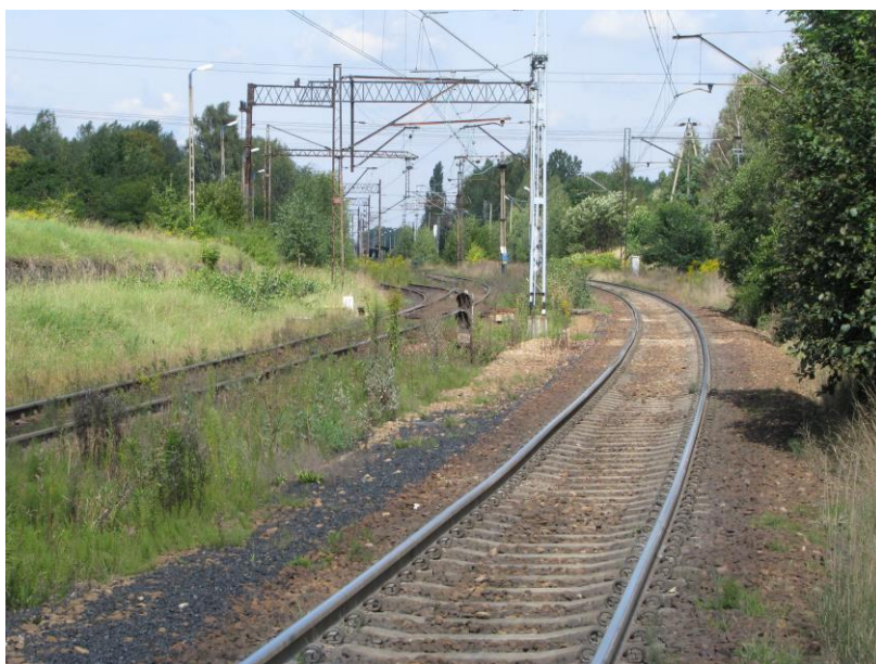
Fot. 2. Mysłowice, RB1. Linia kolejowa nr 138 w kierunku Katowic
