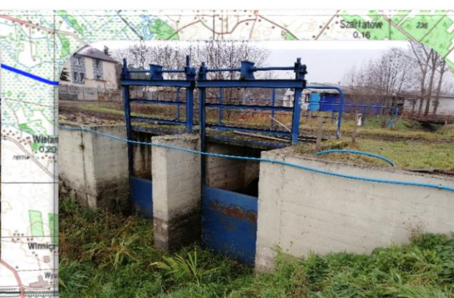
Jaz w km 6+460
