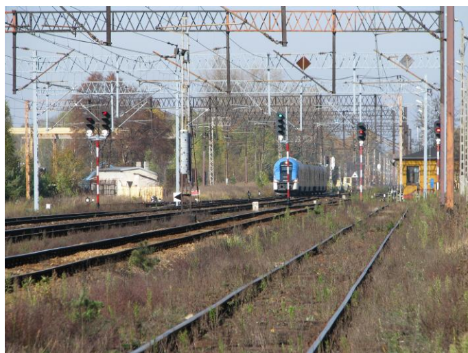
Fot. 2. Poraj, RB1. Linia kolejowa nr 1 w kierunku Częstochowy
