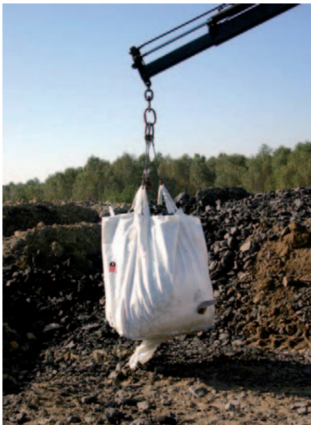
Fot. 4. Azbest pakowany do docelowego zeszkładowania
