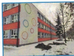
Termomodernizacja Szkoły Podstawowej nr 36 w Częstochowie
