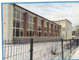
Termomodernizacja Zespołu Szkolno-Przedszkolnego nr 3 w Częstochowie
