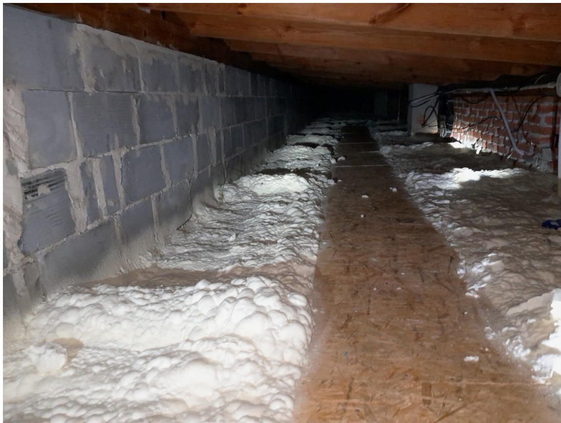
Fot. Ocieplenie wykonane pianą PUR
