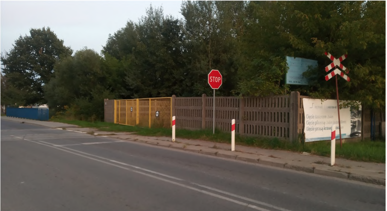
Zdjęcie 1: Przejazd kolejowo-drogowy w ciągu ul. Poselskiej w Częstochowie
