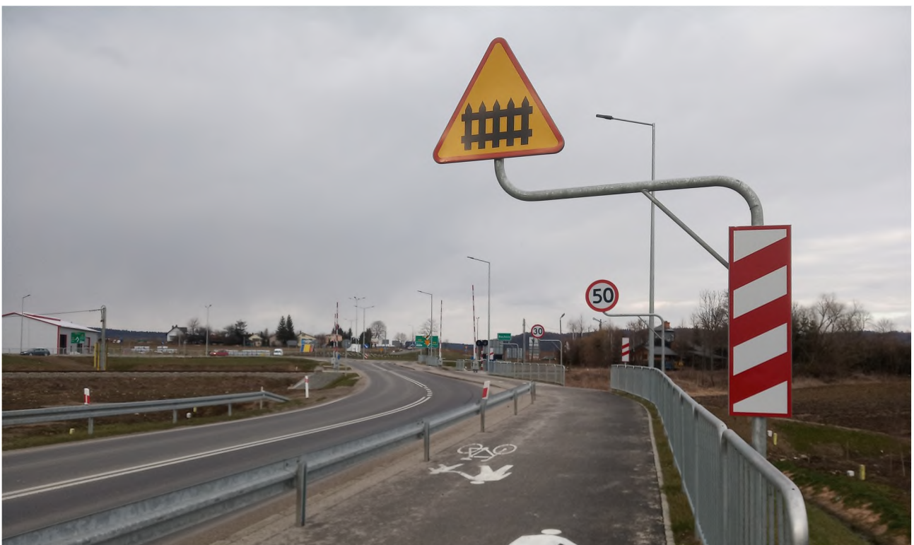
Zdjęcie 2: Przejazd kolejowo-drogowy w ciągu DW835 w Dynowie
