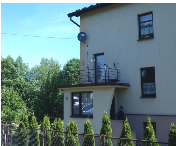
Fot. 6. Skoczów, RB3. Lokalizacja punktu pomiarowego przy ul. Ciężarowej
