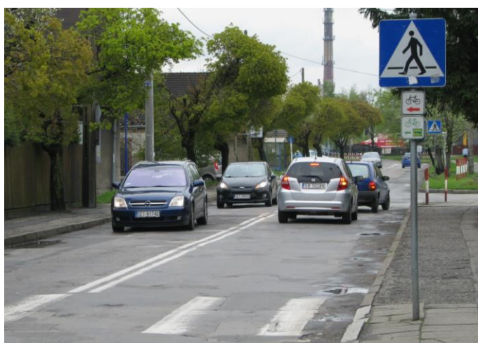
Fot. 5. Skoczów, RB2. Badany odcinek ul. Górny Bór, widok w kierunku ul. G. Morcinka
