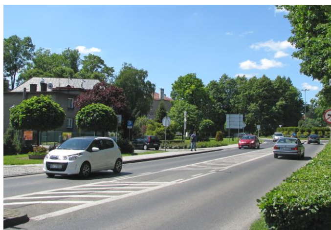
Fot. 3. Skoczów, RB1. Badany odcinek ul. Objazdowej, widok w kierunku ul. Mickiewicza
