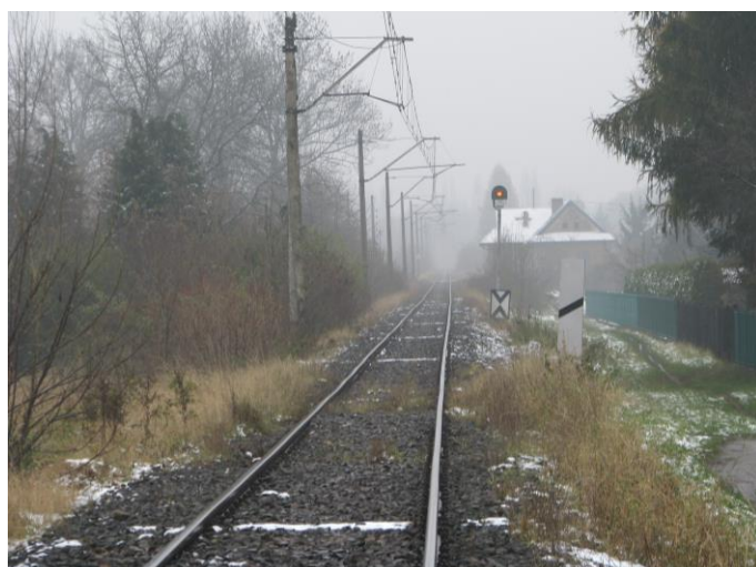
Fot. 12. Skoczów, RB5. Badany odcinek linii kolejowej nr 157, widok w kierunku ul. Bielskiej
