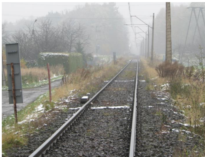
Fot. 13. Skoczów, RB5. Badany odcinek linii kolejowej nr 157, widok w kierunku Chybia
