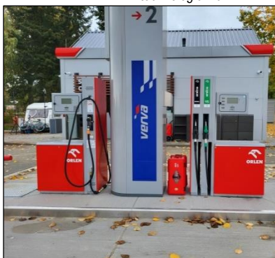
Fot. 3. Obiekty produkcyjno – magazynowe i instalacje technologiczne
