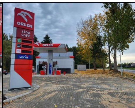
Fot. 5. Obiekty produkcyjno – magazynowe i instalacje technologiczne
