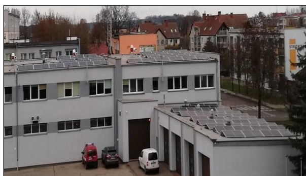
Fot.105. Instalacja fotowoltaiczna w Trzciance
