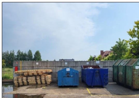
Fot. 2. Obiekty produkcyjno – magazynowe i instalacje technologiczne
