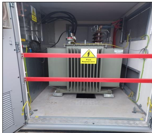
Fot. 79. Rozpoznanie farmy fotowoltaicznej
