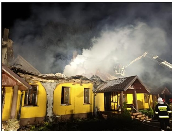
Fot. 48. Pożar budynku mieszkalnego
