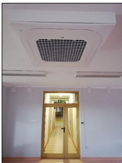
Fot.102. Instalacja urządzeń klimatyzacyjnych w Czarnkowie
