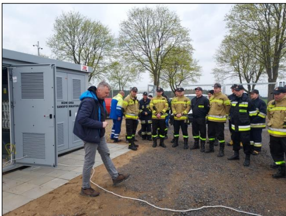
Fot. 78. Rozpoznanie farmy fotowoltaicznej
