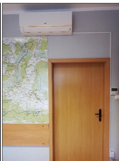
Fot. 103. Instalacja urządzeń klimatyzacyjnych w Czarnkowie
