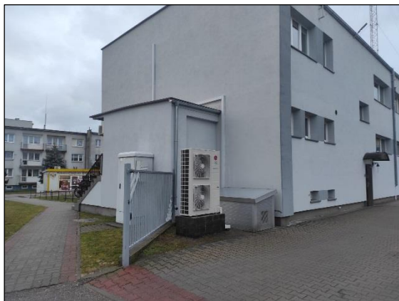
Fot.100. Instalacja urządzeń klimatyzacyjnych w Trzciance
