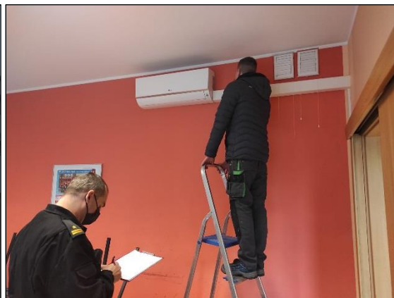
Fot. 101. Instalacja urządzeń klimatyzacyjnych w Trzciance
