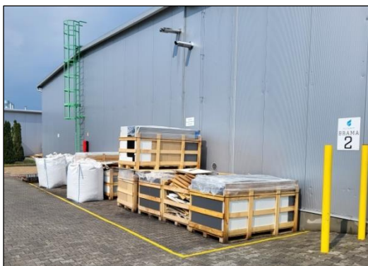
Fot. 1. Obiekty produkcyjno – magazynowe i instalacje technologiczne
