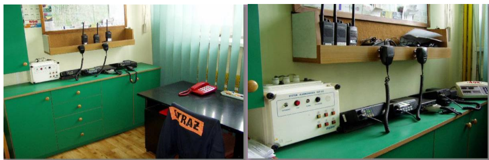
Fotografia nr 10.5. Punkt alarmowo – dyspozycyjny OSP Barczewo
