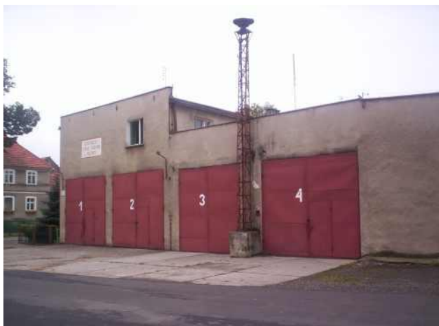
Fotografia nr 10.2. Widok masztu i syreny elektrycznej (elektromechanicznej)
