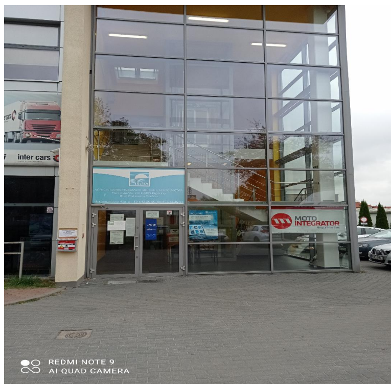
Wejście od ul. Grunwaldzkiej
