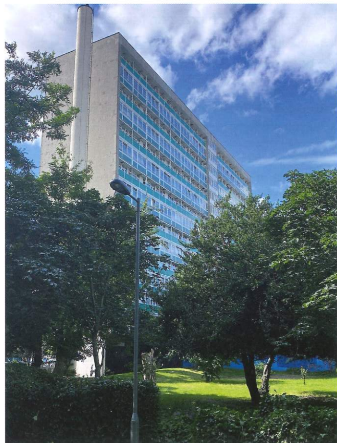
📷 Budynek Lakanal House w 2021 r. fot. Secretlondon / Wikipedia (CC BY-SA 4.0)
