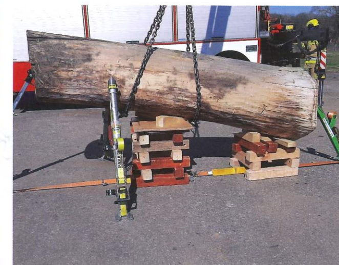
Stabilizacja gabarytu w innej konfiguracji sprzętowej fot. Rafał Podlasiński
