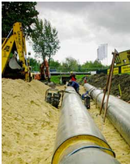
Montaż ciepłociągu w ulicy Zjednoczenia. Fot. R. Malarczyk
