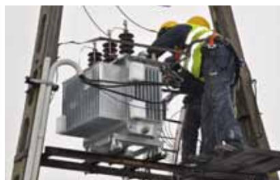
Montaż transformatora. Fot. ENEA Operator Sp. z o.o.
