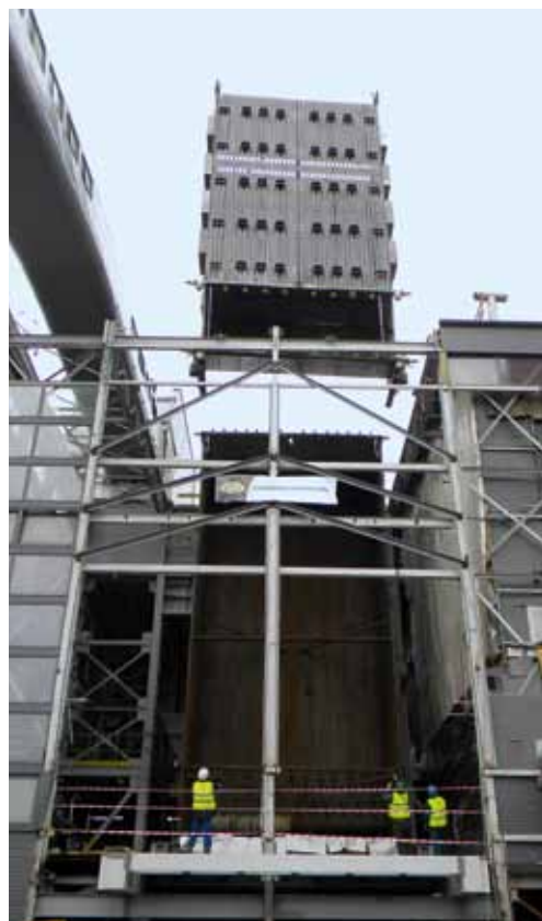
Montaż ekranów kotła OR-50N. Fot. M. Kansy
