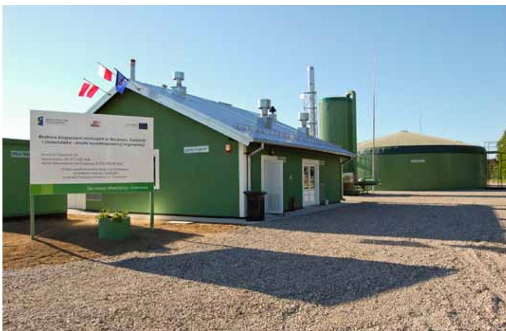
Biogazownia rolnicza w Naclawiu. Fot. Poldanor S.A.
