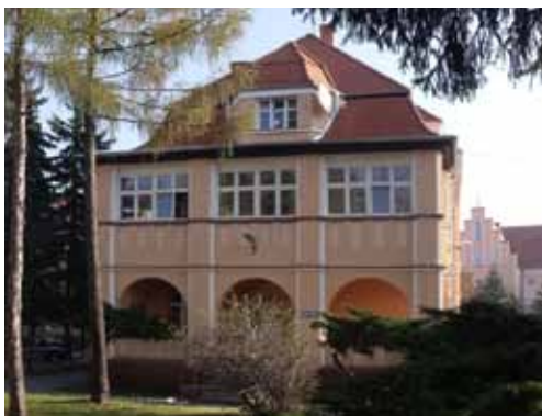
Budynek neurologii. Fot. D. Zaleska
