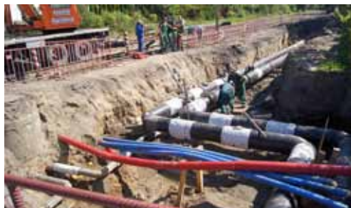
Modernizacja sieci ciepłowniczej. Fot. Z. Tkaczyk
