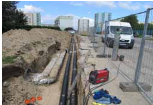
Widok starych i nowych rur. Fot. W. Ciechanowicz
