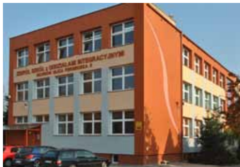
Obiekty poddane termomodernizacji, po realizacji. Fot. M. Strama
