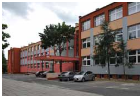
Obiekty poddane termomodernizacji, po realizacji. Fot. M. Strama
