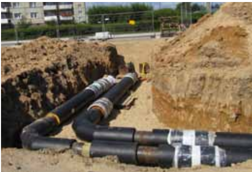
Sieć ciepłownicza Dn 300 wzdłuż ul. J. Korczaka. Fot. W. Ciechanowicz
