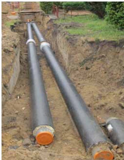
Montaż rur preizolowanych wzdłuż ul. Jackowskiego. Fot. W. Ciechanowicz
