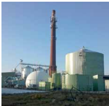
Biogazownia. Fot. S. Łazarski
