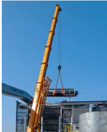
Montaż walczaka na kotle OR-50N. Fot. M. Kansy
