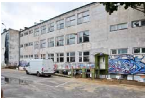
Obiekty poddane termomodernizacji, przed realizacją. Fot. M. Strama
