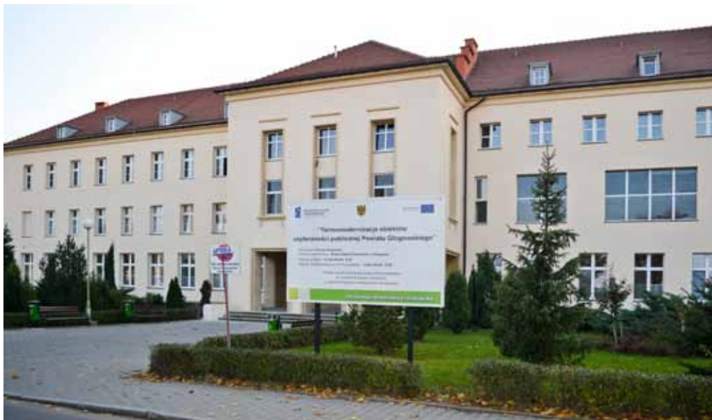
Tablica informacyjna przed jednym z budynków po termomodernizacji. Fot. M. Strama
