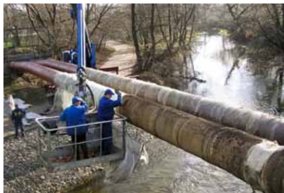
W trakcie prac modernizacyjnych. Fot. LPEC Lublin
