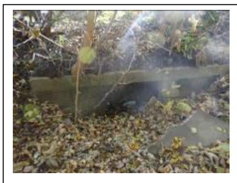
v. przepust kamienny płytowy km 7,702
