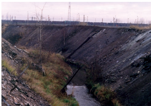
Fot. 3. Rzeka Stoła pomiędzy zwałowiskami nr 3 i 3a
