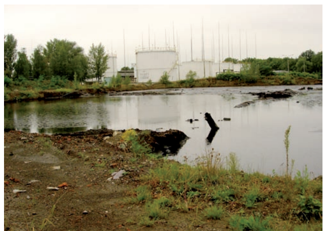
Fot. 6. Składowisko kwaśnych smół porafinacyjnych tzw. „dołów kwasowych” przed rozpoczęciem prac rekultywacyjnych
