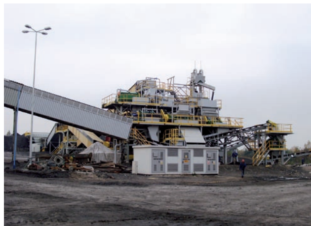
Fot. 2. Widok na instalację odzysku odpadów wydobywczych Zakładu Przerobczego Nr 12 „HALDEX-Panewniki”
