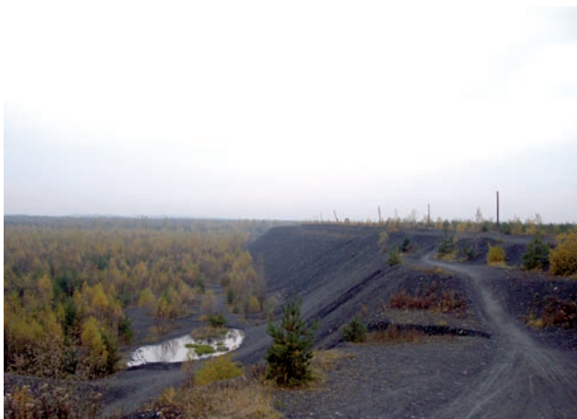
Fot. 1. Widok na nieeksploatowaną część Obiektu Unieszkodliwiania Odpadów Wydobywczych „Panewniki”
