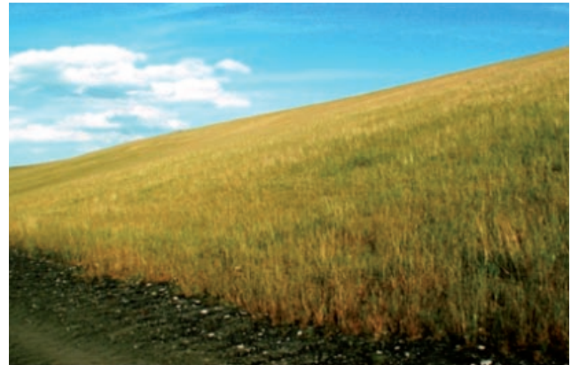
Fot. 5. Zrehabilitowana skarpa metodą Frisol w 2008 roku (Wystawa południowa). Zdjęcie wykonane w 2012 roku
