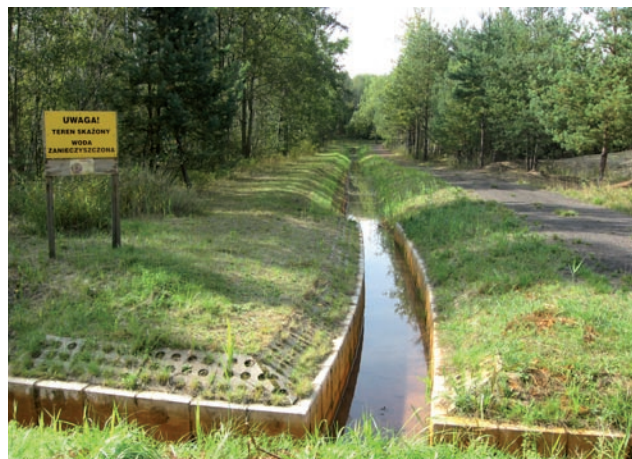
Fot. 5. Centralne Składowisko Odpadów „Rudna Góra” – rowy odwadniające
