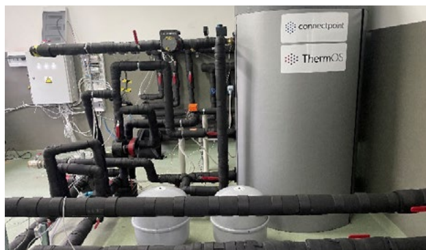
■ Bufor zasilania systemu wraz z instalacją
