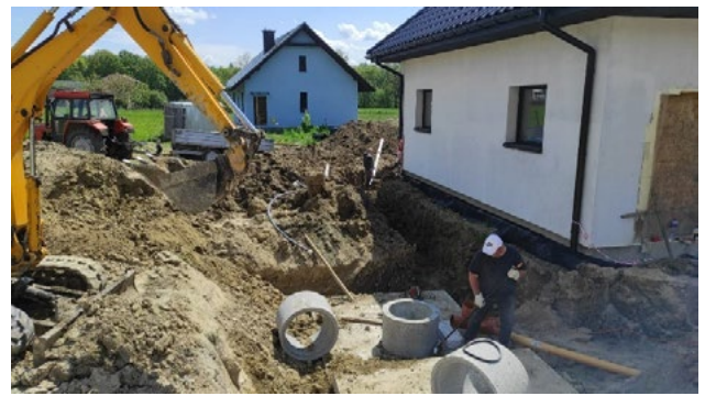
■ Prace montażowe systemu do retencjonowania i oczyszczania wody deszczowej dla budynku jednorodzinny w Bieruniu, realizowane przez wykonawcę AquaSmart z Krakowa
