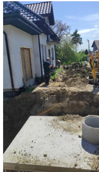
■ Prace montażowe systemu do retencjonowania i oczyszczania wody deszczowej dla budynku jednorodzinny w Bieruniu, realizowane przez wykonawcę AquaSmart z Krakowa
