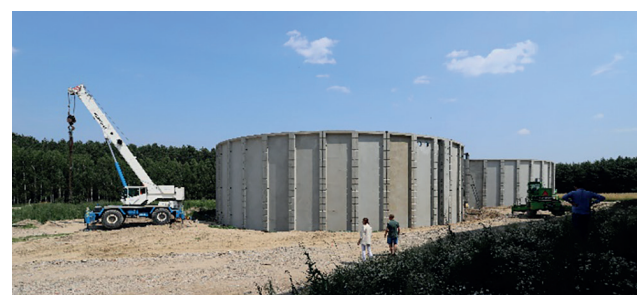
■ Fermentator budowany na potrzeby elektrociepłowni OZE
