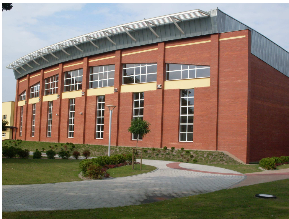
Fot. 1 Hala sportowa ul. Szkolna / Kosynierów
