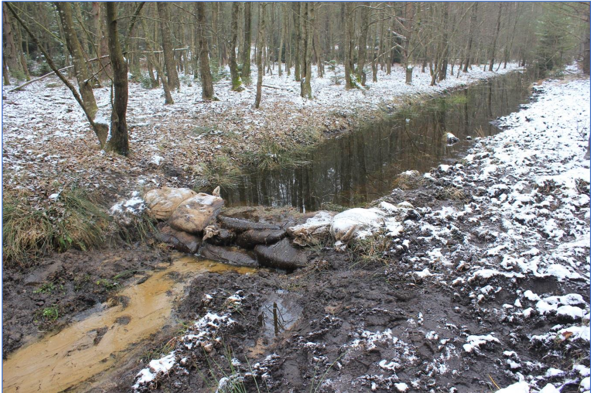
Wykonanie przetamowań rowów w rezerwach przyrody „Las Ostrzycki” i „Torfowisko Potoczek”
