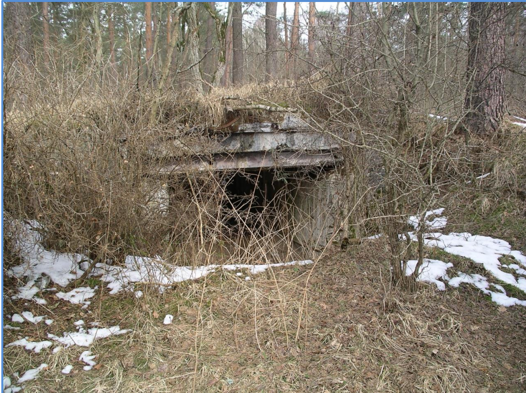
Jeden ze schronów na linii obronnej między jeziorami Dolgie i Wielimie
